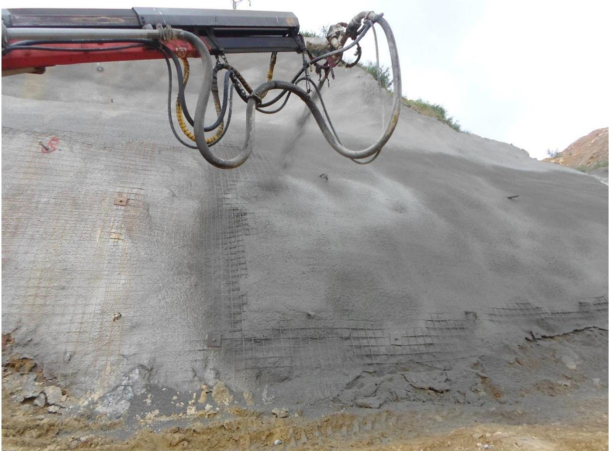
**Photo prise lors de la projection du béton sur talus**
