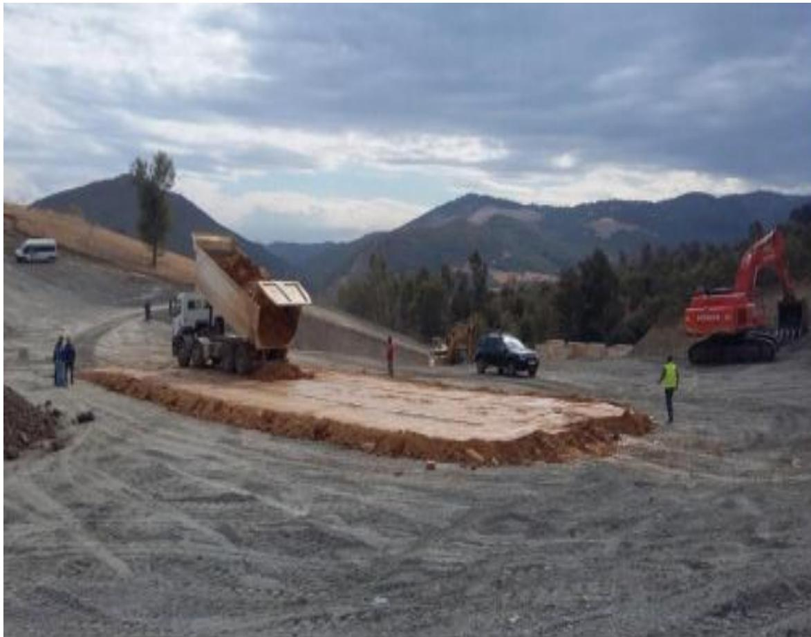
**Figure 7 : La réalisation d'une planche d'essais**
