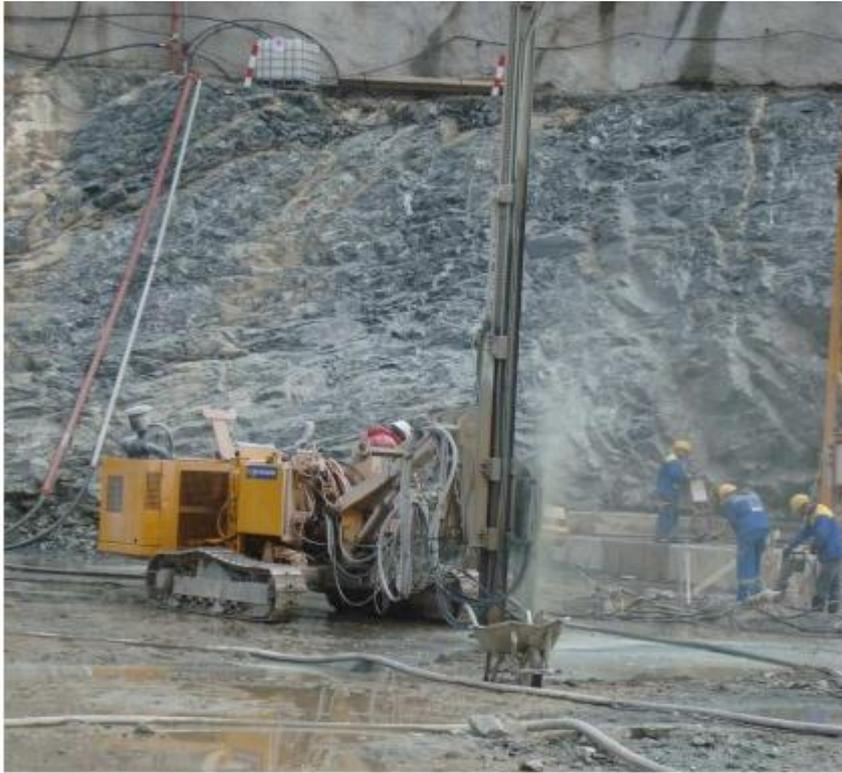
**Figure 6** :La machine d'injection
