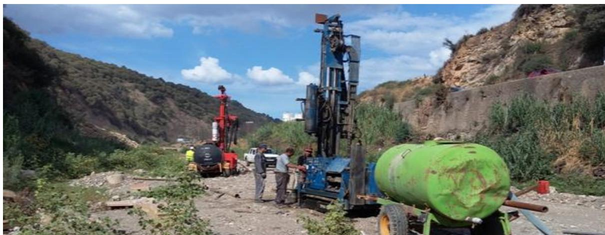
**Figure 2** : réalisation des carottages SPT
