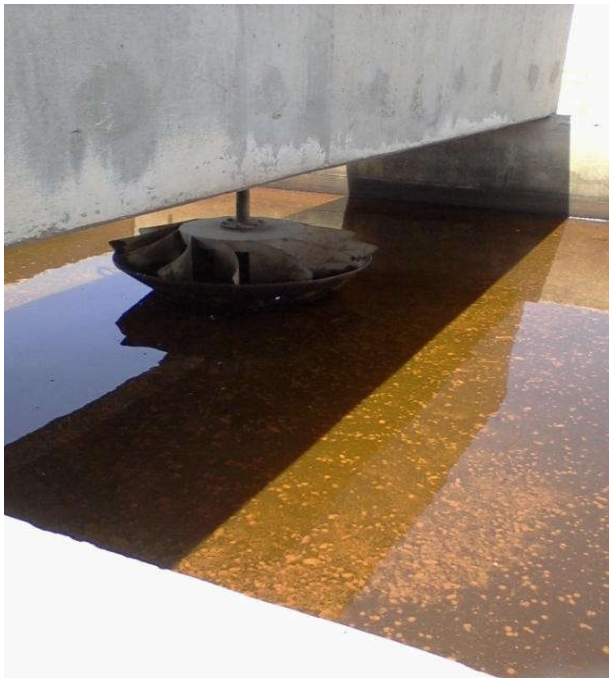
Figure V.3 : Etat bassin d'aération actuel.
