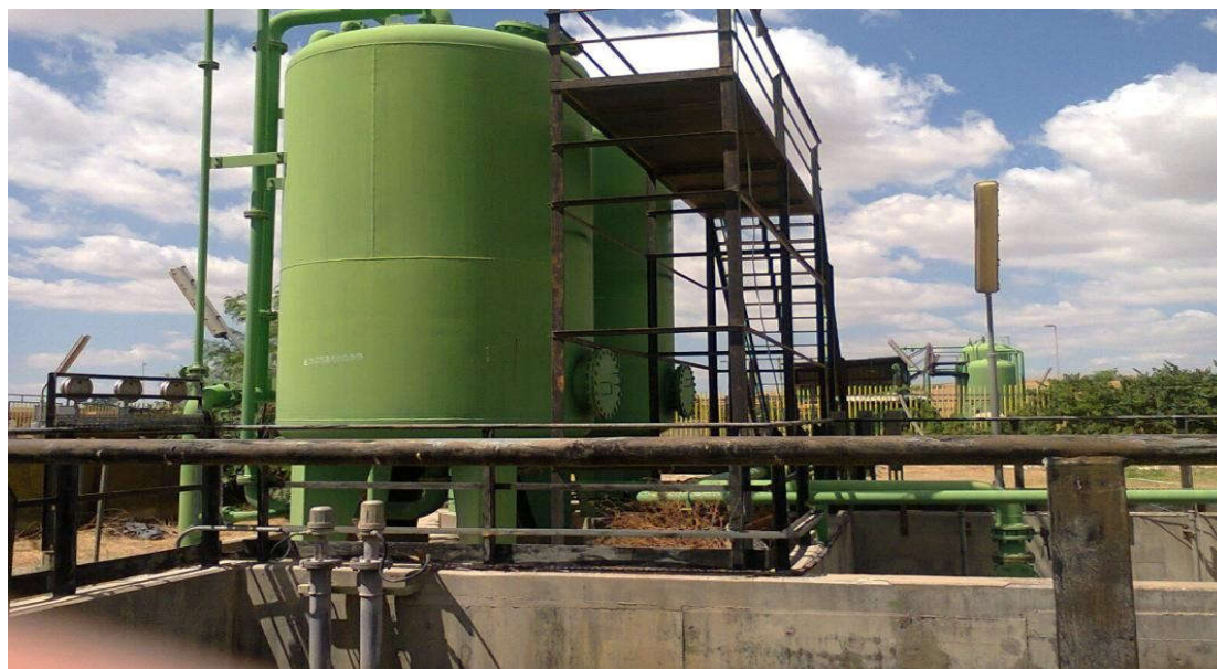
Figure IV.2 : Les bonbonnes de charbon actif sur site
