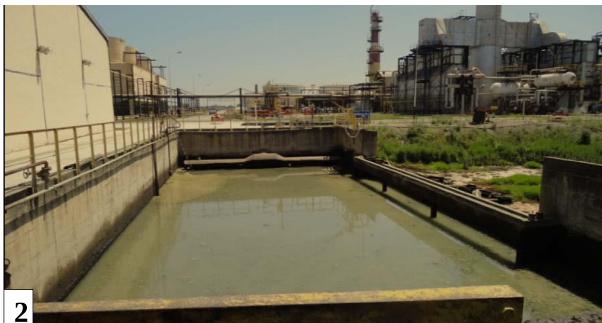
Figures A.2 : bassins des eaux pluviales
