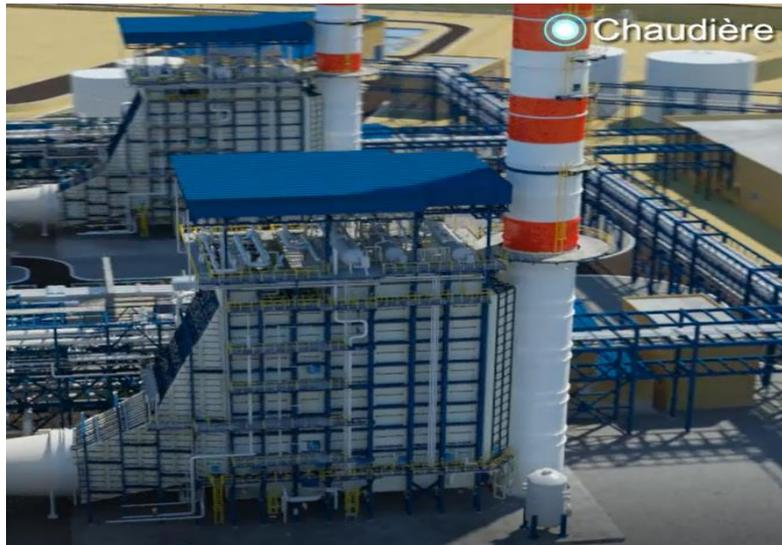
**Figure 2.5:** chaudière de récupération HRSG. [1]
