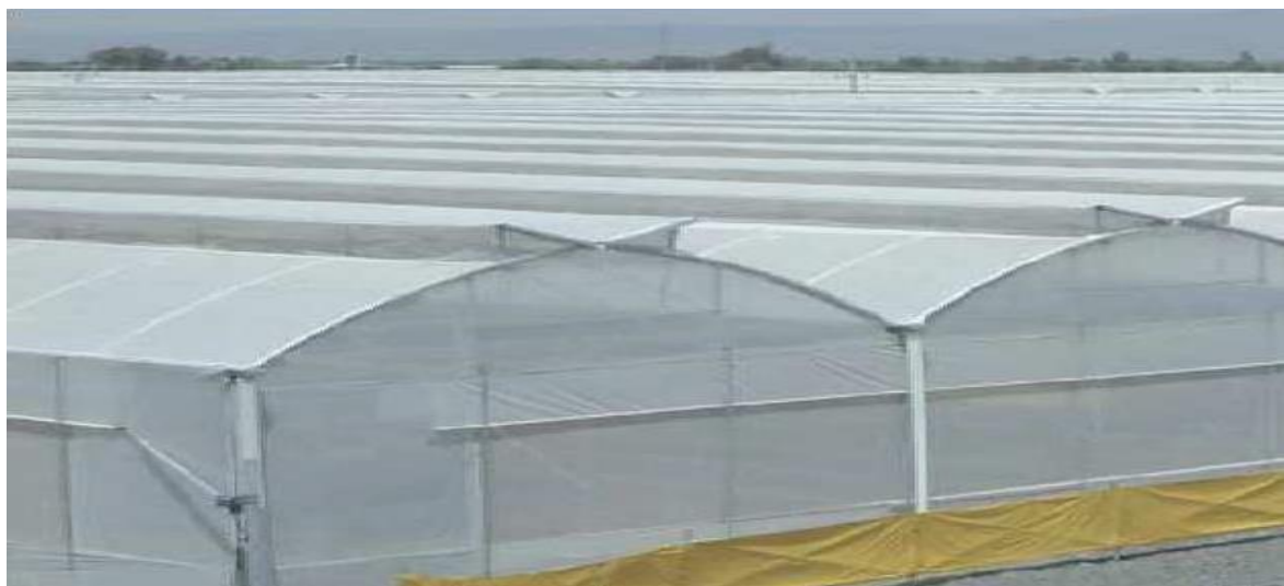
Figure 1-2 Une serre multi-chapelle
