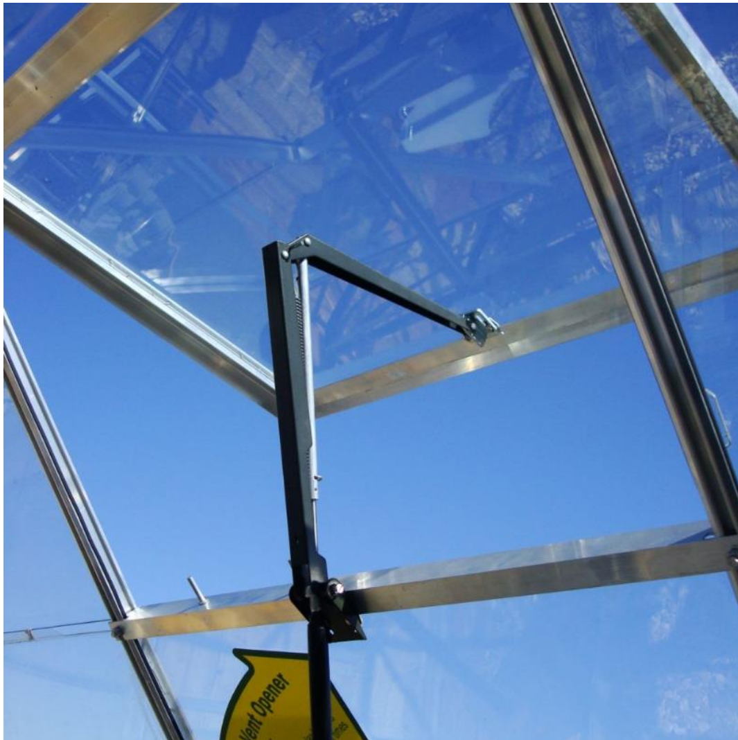
Figure 1-7 Ouverture et fermeture d'une fenêtre de serre automatique
