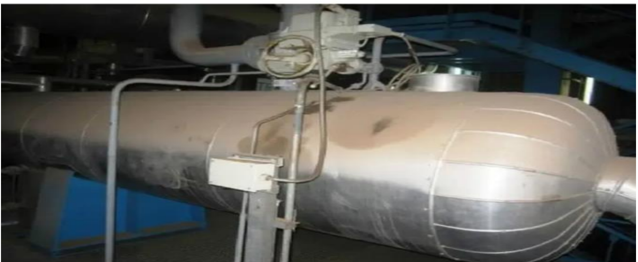
Figure1.10 : Réchauffeurs basse pression.
