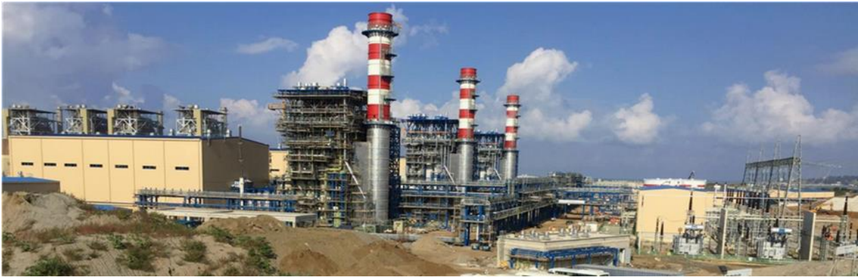
Figure 1.3 : la nouvelle centrale électrique Cap-DJINET
