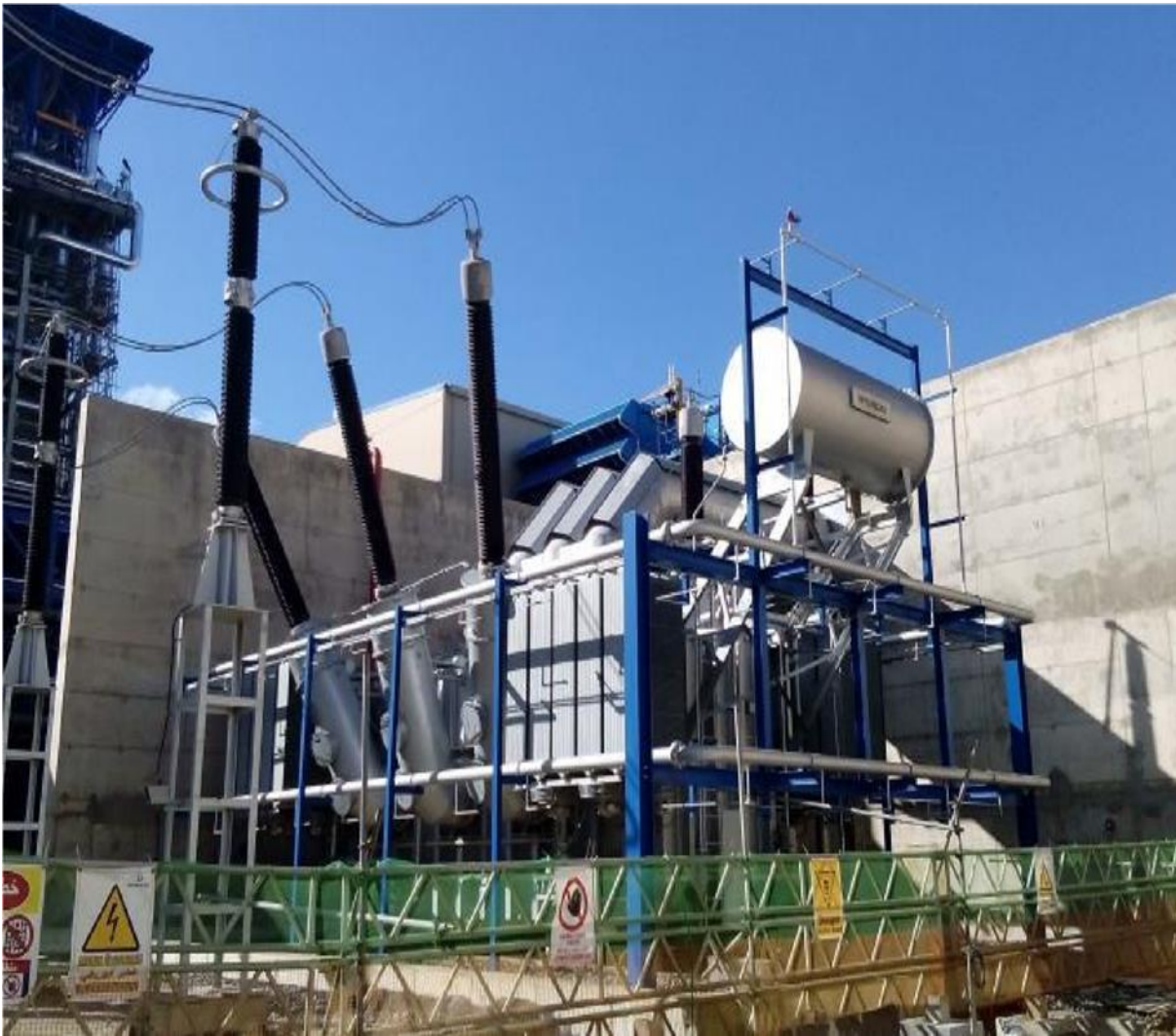
Figure 1.8 : Transformateur principal.
