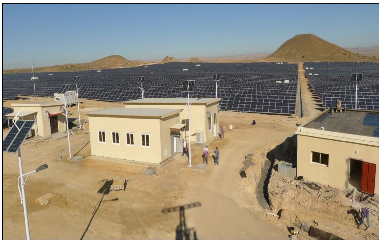
Figure N°35 : La centrale photovoltaïque oued El kebarit dans la wilaya de Souk-Ahrass
