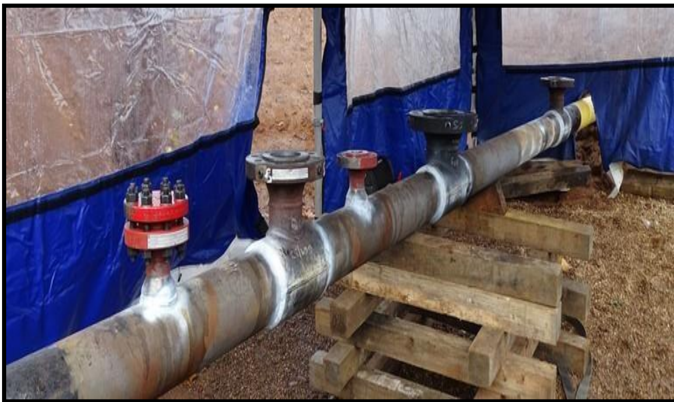
FIG.II.4 : Soudage du tee entre les deux tuyaux.
