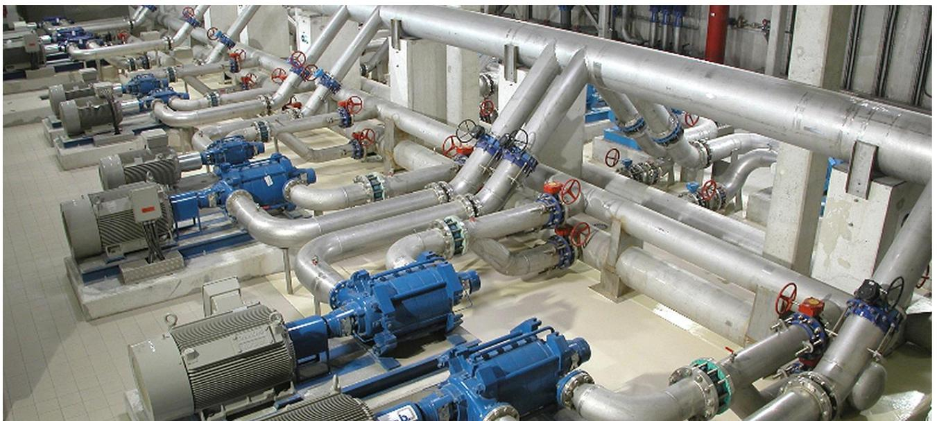
**Figure I.11 :** Déshumidification station de pompage et traitement d'eau
