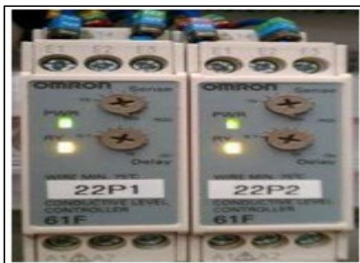
**Figure IV. 30 :**Capteur de niveau.
