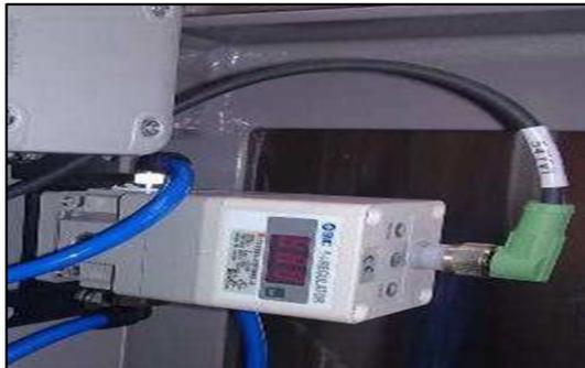
**Figure IV. 29 :**la vanne électro –pneumatique.
