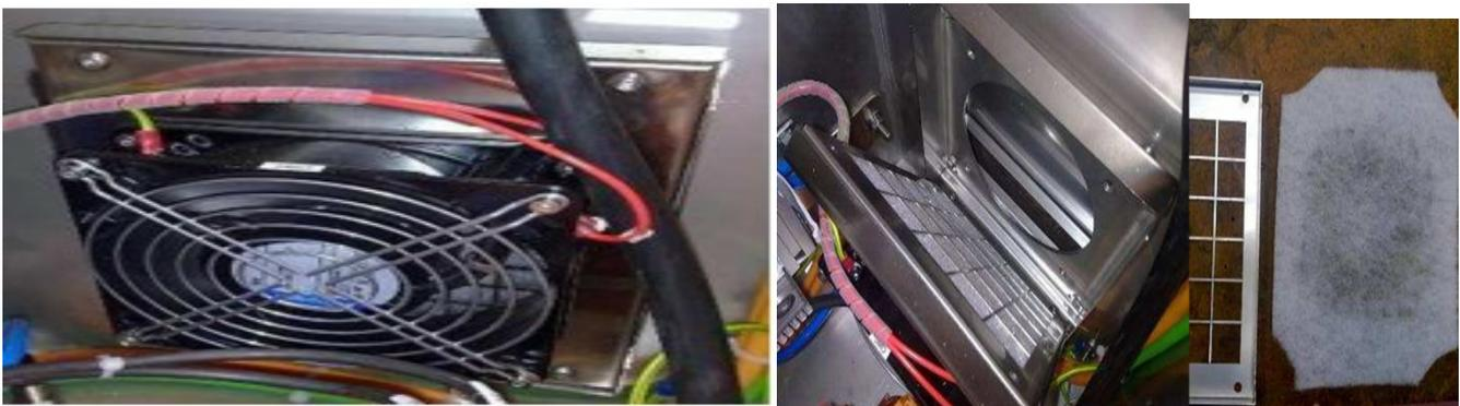
**Figure IV. 39 :**Vérification et entretien du boîtier de filtration d'air.
