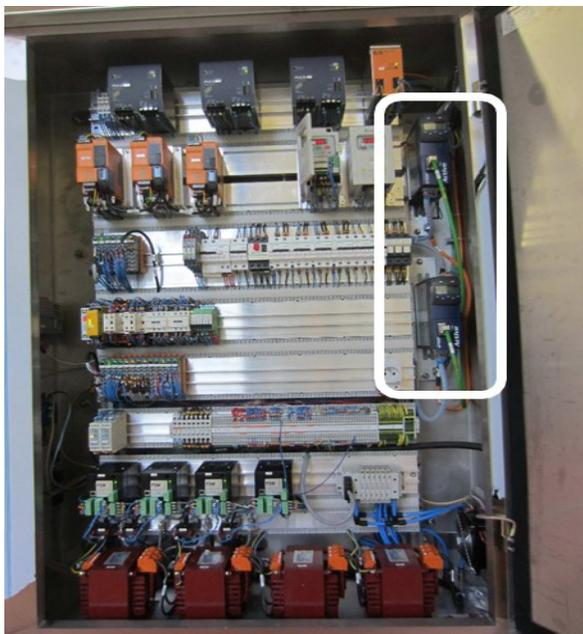
Figure IV. 44 : Remplacement d'une carte d'axe.
