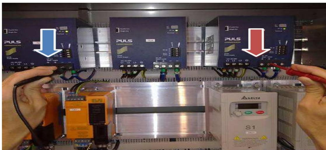
Figure IV. 45 : Vérification de la tension de l'alimentation continue.
