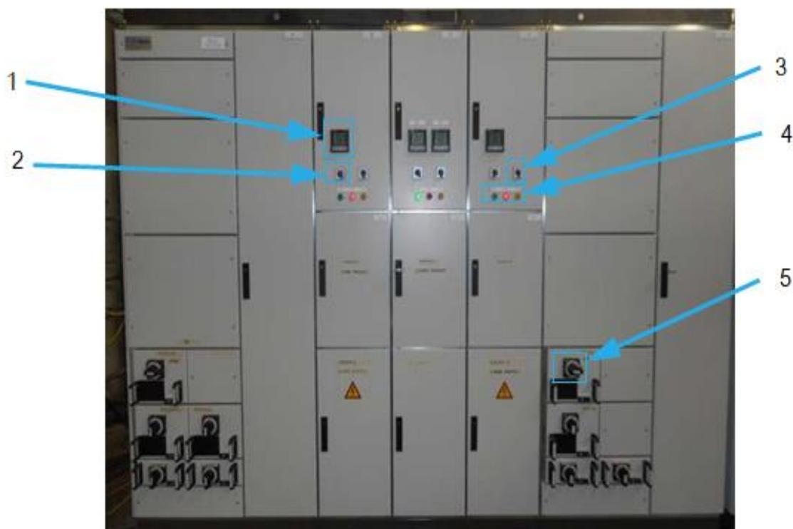
**Figure III.22.** Interface du centre de commande du moteur : voyants et commutateurs
