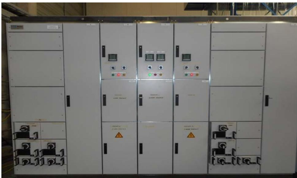
**Figure III.18.** Le centre de commande du moteur (MCC)
