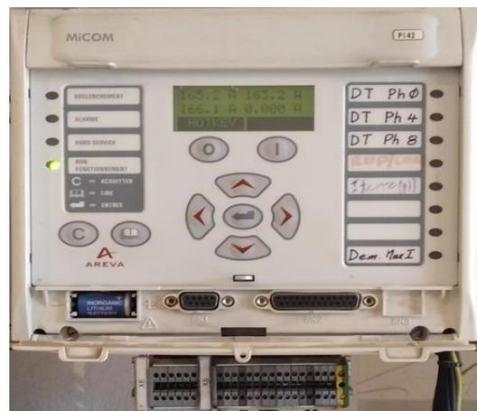
Figure II-17: Protection de secours d'une ligne 60KV, MICOM P142. [26]
