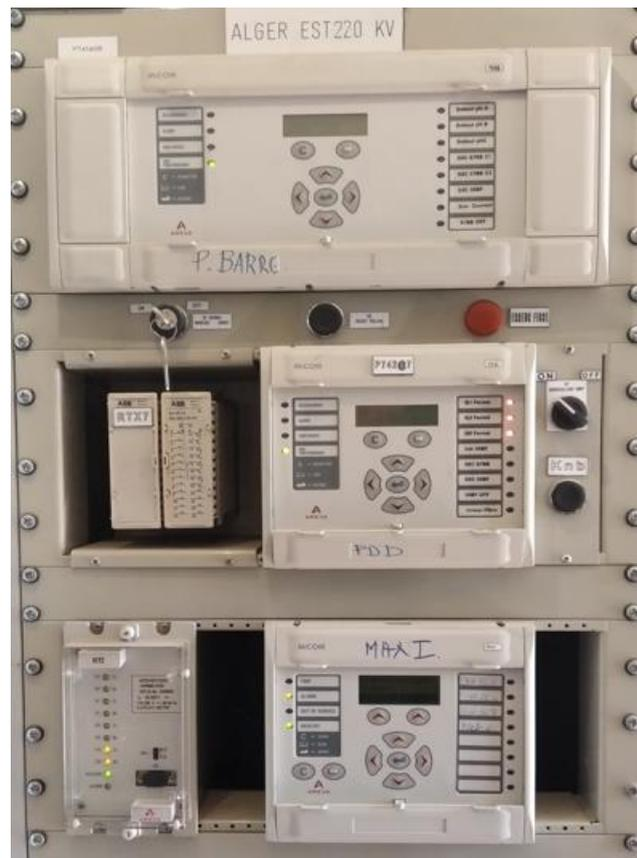
Figure II-18: Armoire de contrôle barre 220KV (protection différentielle barre MICOM P741+ PDD MICOM P742+ max I MICOM P141).
