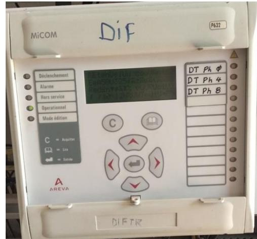
Figure II-20 : Protection différentielle
