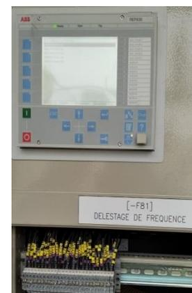
Figure III-1 : (F81) Relais de délestage de fréquence marque ABB
