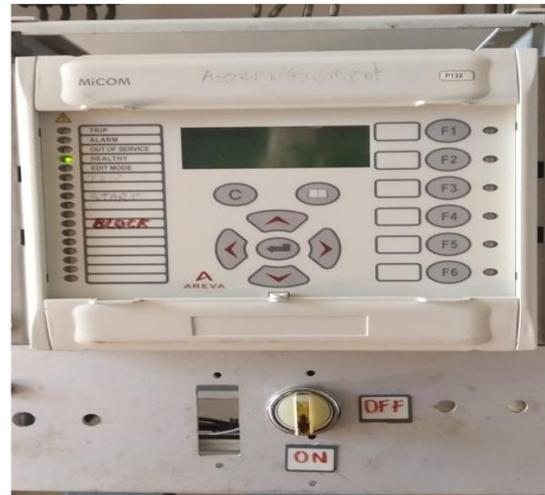
Figure III-10 : Relais d'asservissement de puissance MICOM P132, Installé sur départ 220KV EHP et EHAMP au poste 220kv BOUDOUAOU.
