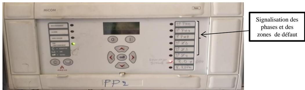
FigureII-3 : Protection de distance d'une ligne 220KV-MICOM P444-.
