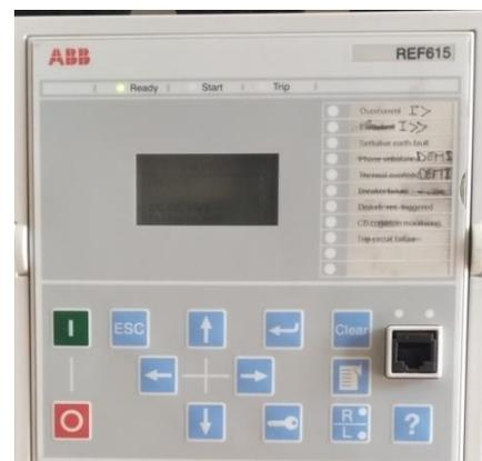
Figure II-22: Protection –ABB- à maximum de courant côté HT d'un transformateur 220/60KV
