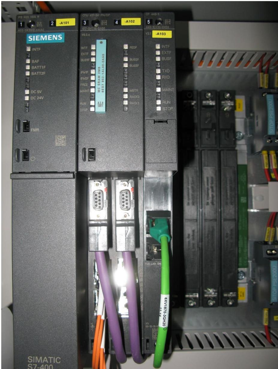
Figure 6.1 : l'automate programmable industriel
