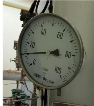
Figure 3.4 : indicateur de température locale
