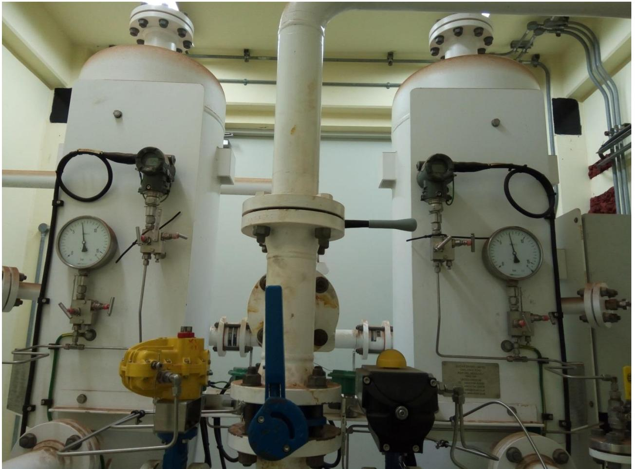
Figure 2.2 : sécheur d'air ATLAS COPCO
