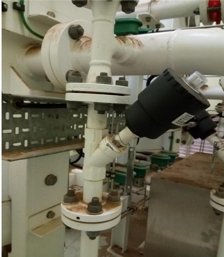
Figure 3.7 : vanne à commande par piston
