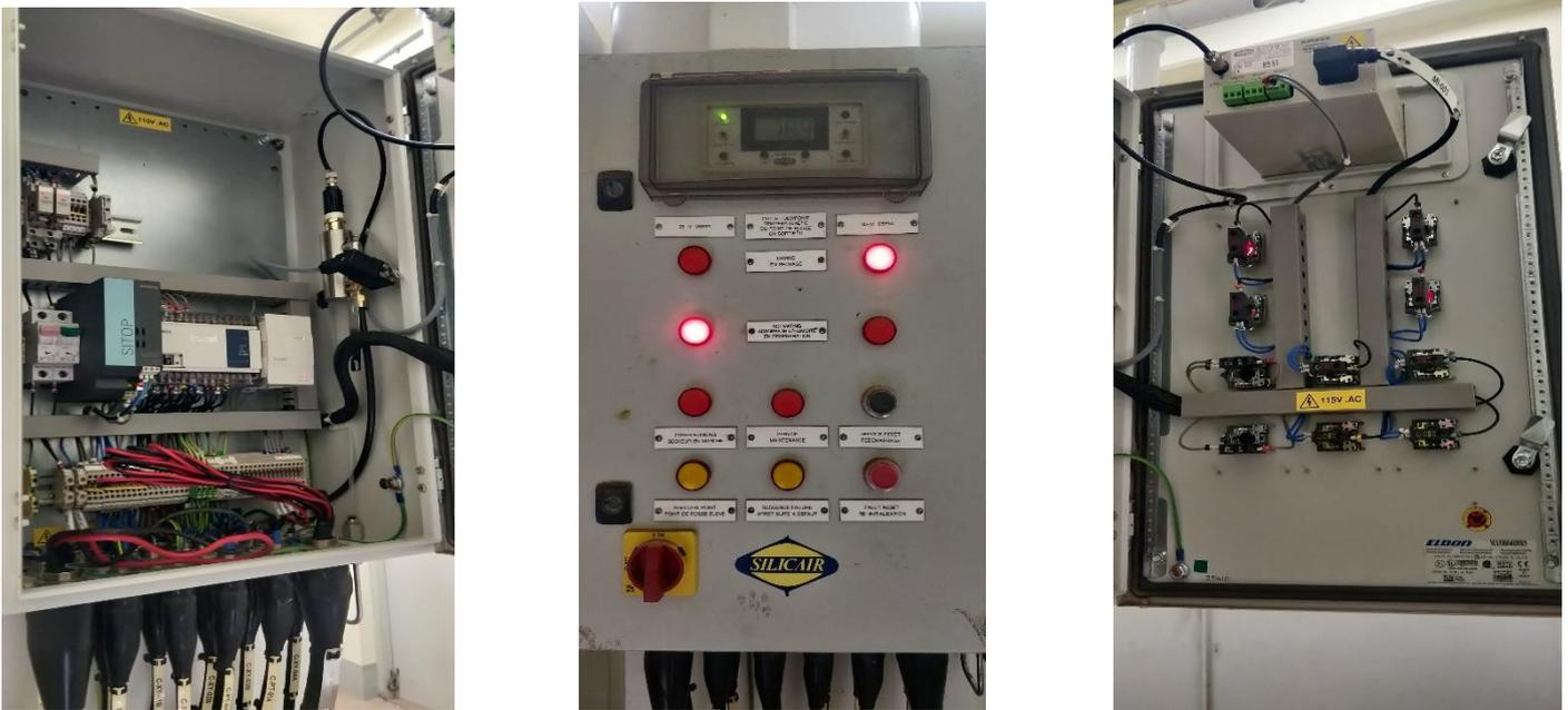
Figure 3.8 : armoire électrique commandant le sécheur d'air
