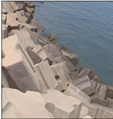
Figure I.12 Photographie des Dalots utilisés au large de la mer au niveau de la commune de Tipaza.
