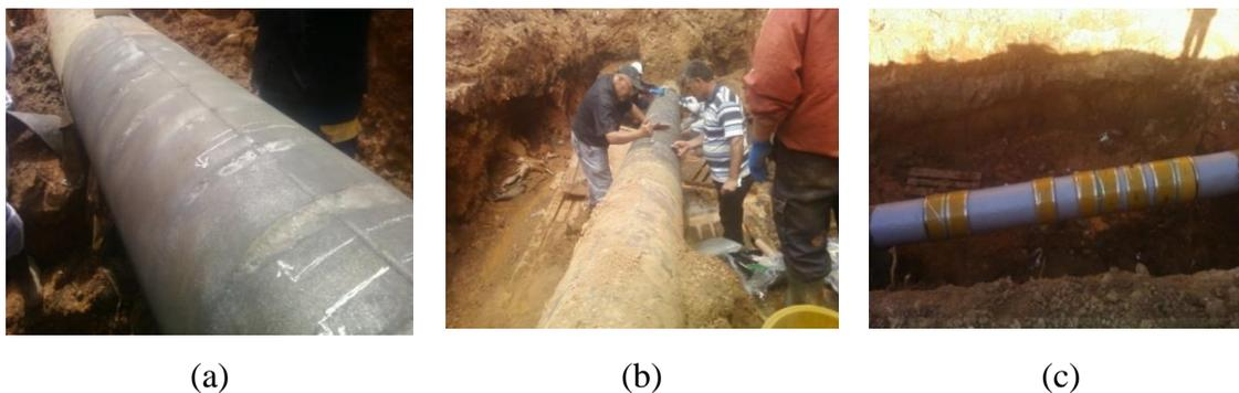
Figure II.8 : Méthode de réparation par manchon composite (RTO, 2013). (a) Défaut détecté, (b) Préparation de la surface, (c) Réparations localisées sur un tuyau en acier corrodé.
