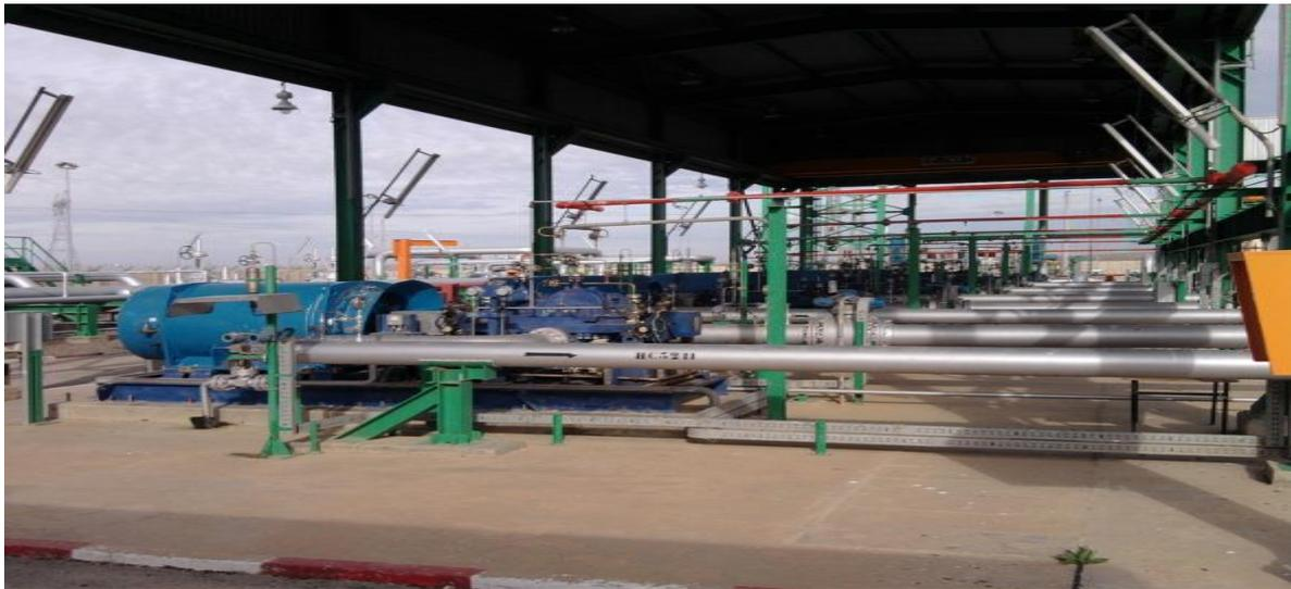
**Figure I.14 :** Disposition des électro- pompes principales GEP A, B, C, D et E
