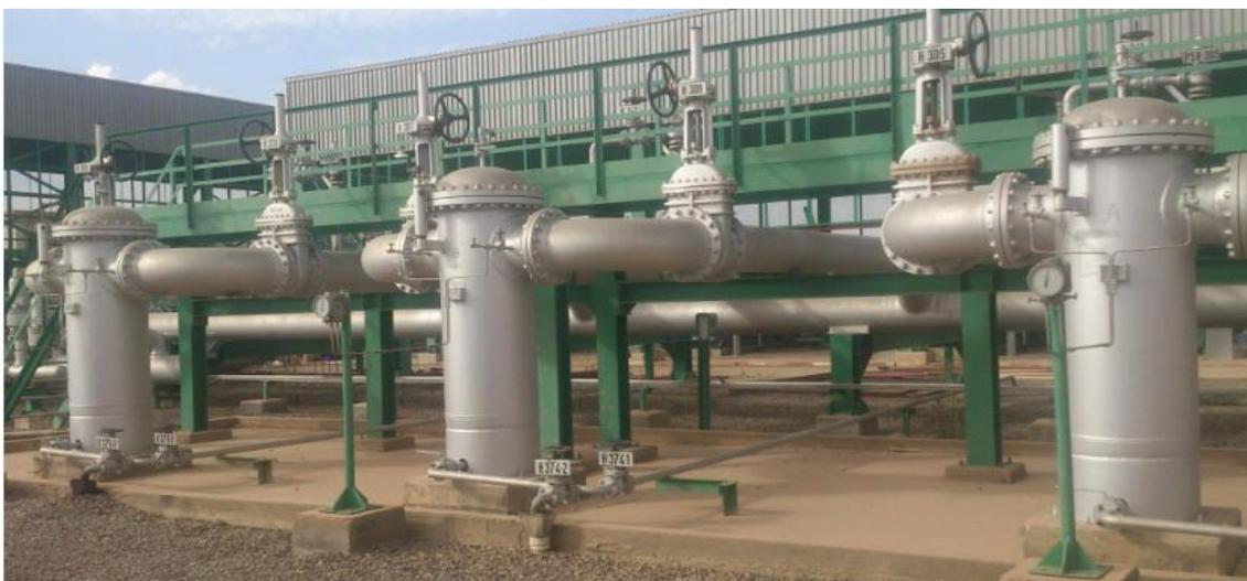
**Figure I.11 :** Emplacement des filtres A, B et C.
