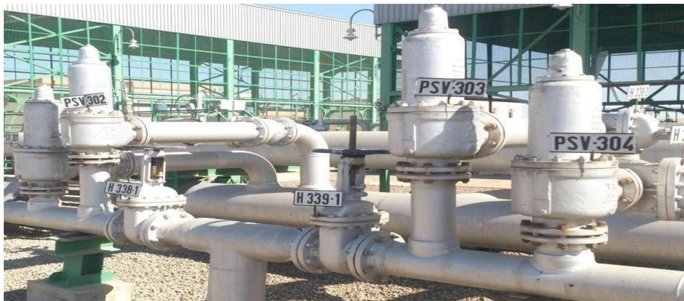
**Figure I.15 :** Soupapes de décharges PSV 303 et 304
