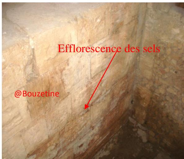
Fig.2.7.Efflorescence des sels sur la surface des pierres du mur antique
