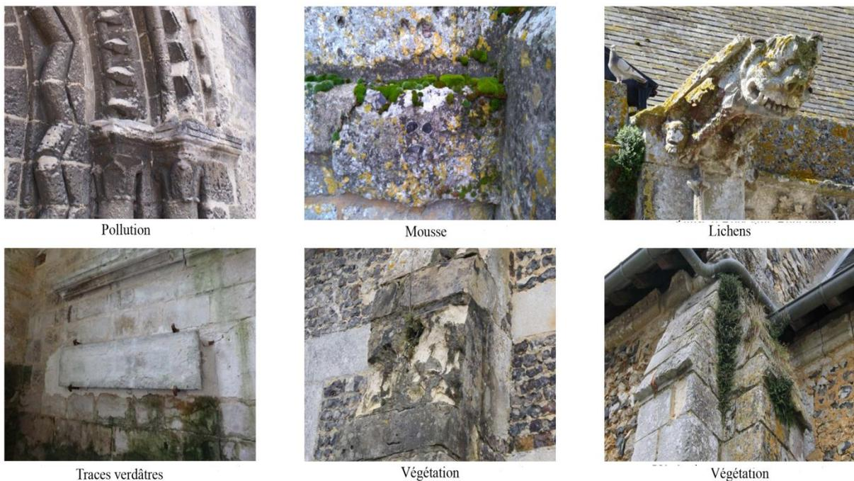
Fig.1.20. Les principales formes d'altération de la pierre en œuvre<sup>49</sup>.
