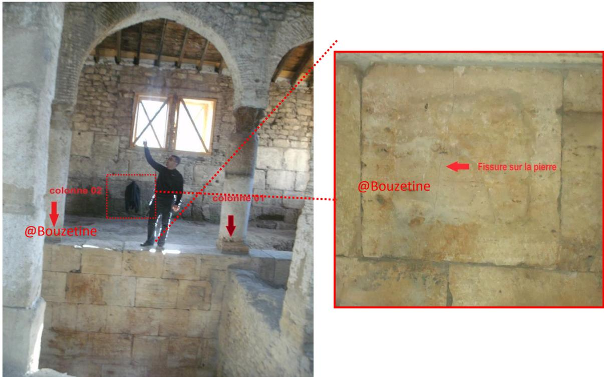
Fig.2.2.Fissure sur les pierres du mur antique Sud.
