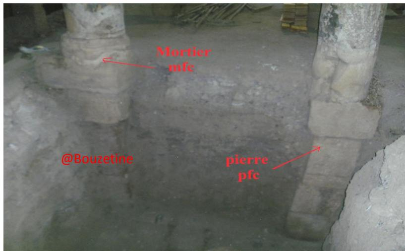
Fig.4.11. Technique de la mise en œuvre des fondations centre.
