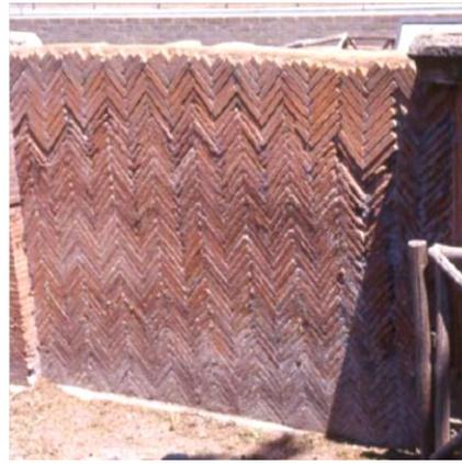
Fig .1.27.Appareil en épi<sup>65</sup>
