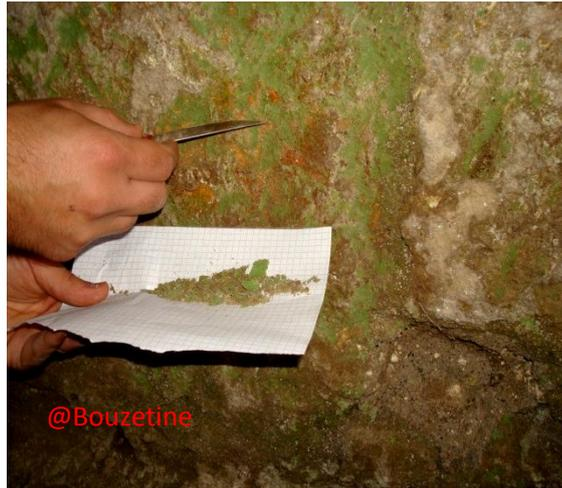
Fig.2.14.Présence des lichens sur les pierres aux pieds des murs de la salle de prière.
