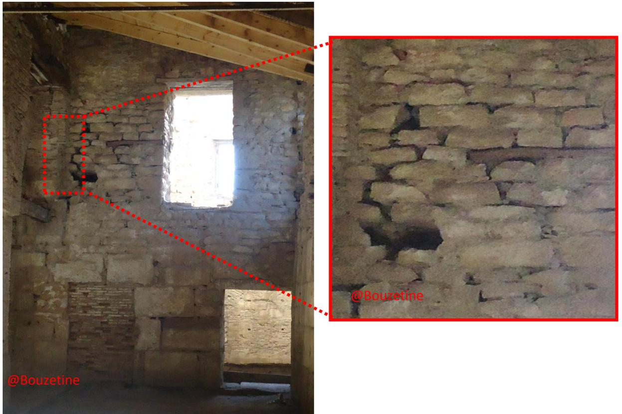
Fig.2.3.Fissuration dans la maçonnerie sur l'angle sud-est de la salle de prière.
