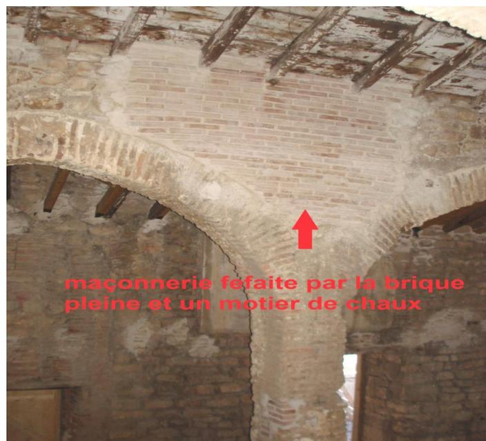
Fig.2. 35. Maçonnerie refaite par la brique pleine et le mortier de chaux.
