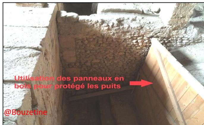
Fig.2.32.Protection par des panneaux en bois du puit Sud.
