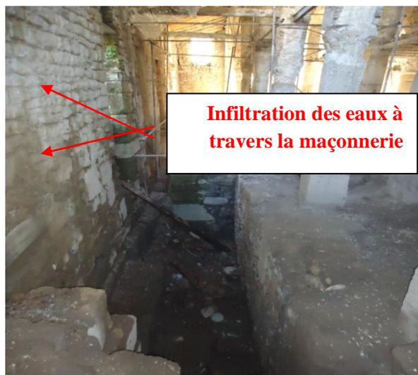
Fig.2.9. Infiltration des eaux de pluie à travers le mur Nord de la salle de prière.
