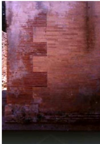
Fig.1.28.Chaine d'angle avec des briques de différentes couleurs<sup>66</sup>.
