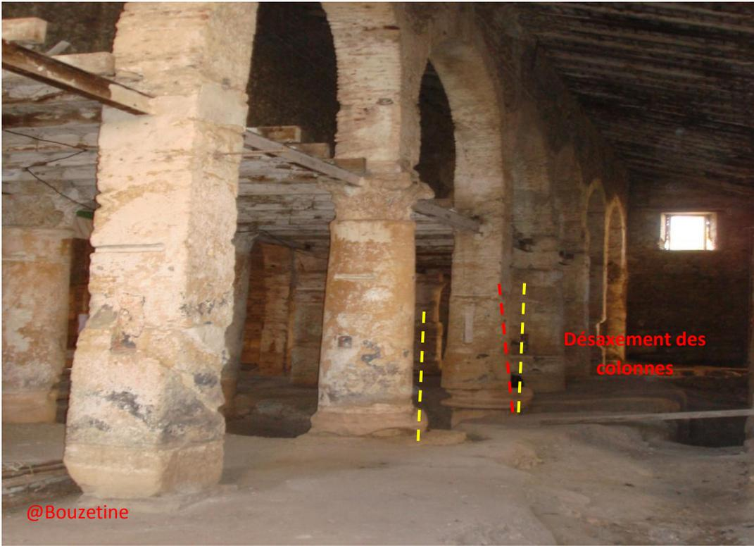
Fig.2.6. Désaxement des colonnes sous le poids du plancher.
