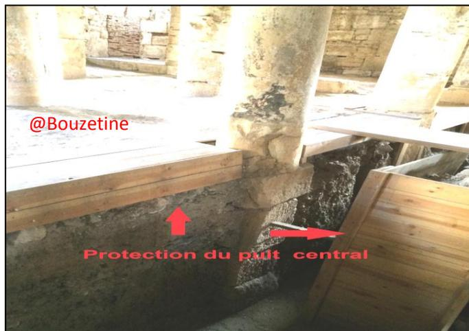
Fig.2.33.Protection du puit central de la salle de prière.
