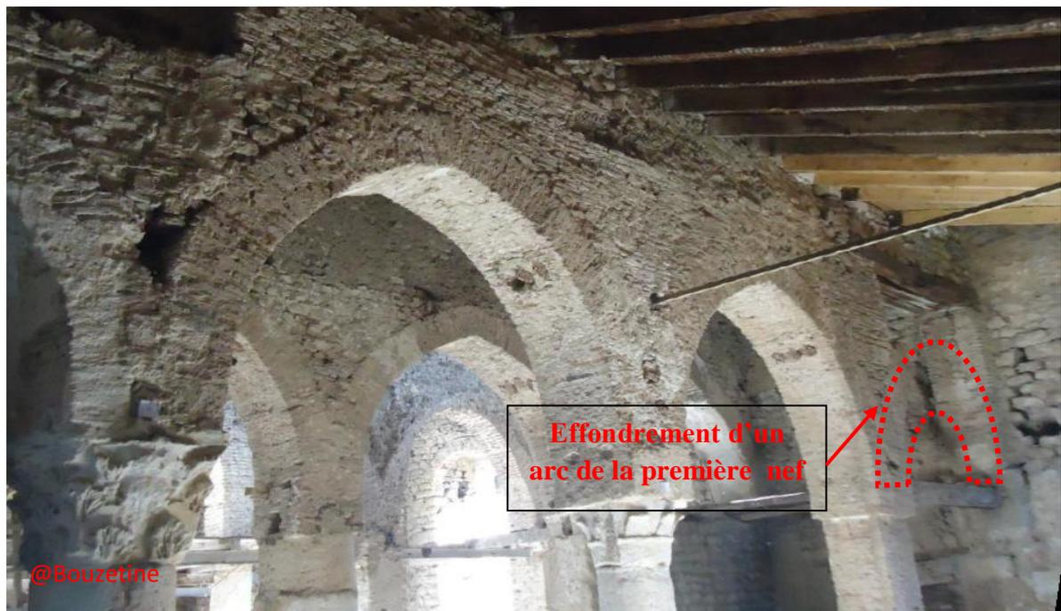
Fig.2.4.Effondrement d'une arcade sur les deux dernières colonnes de la première nef.
