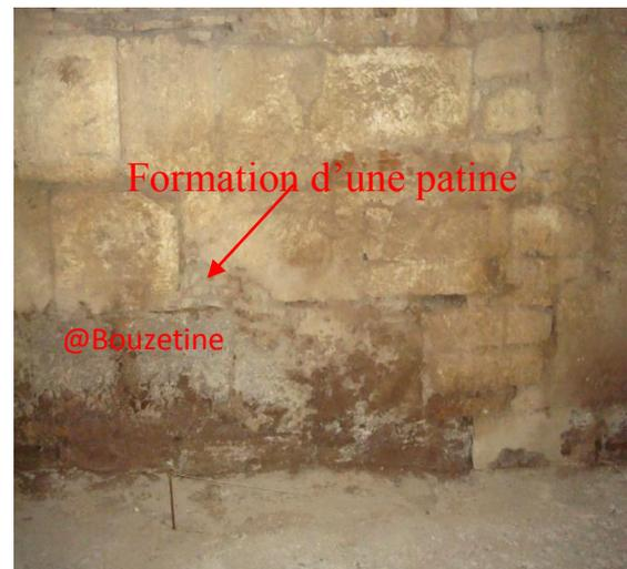
Fig.2.8. Formation des plaques sur la surface des pierres du mur Nord
