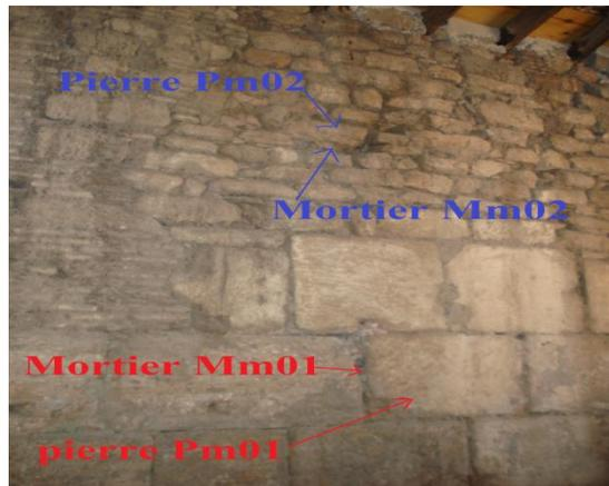
Fig.4.27. échantillonnage de pierre et de mortier sur le mur de l'enceinte.
