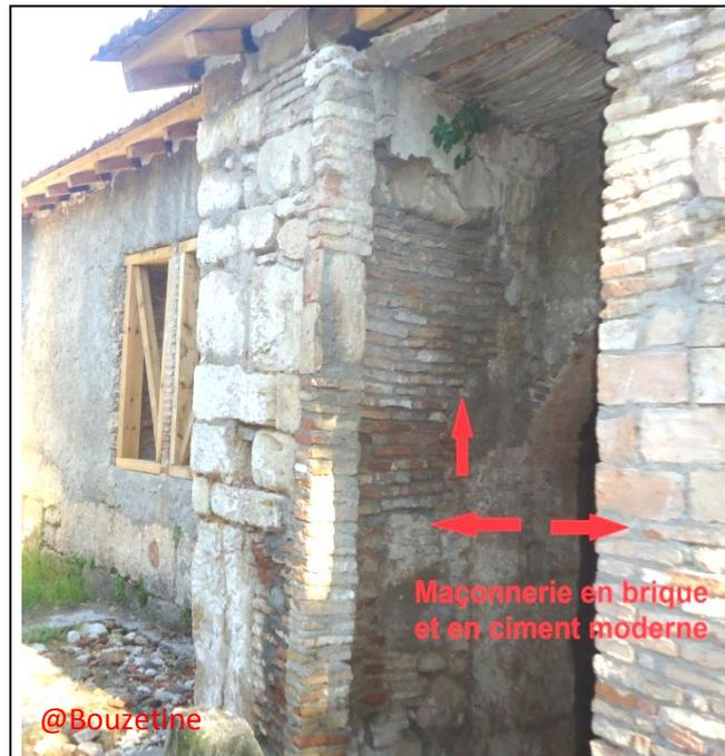
Fig.3.21.Mihrab vu de l'extérieur avec la présence d'une maçonnerie moderne.
