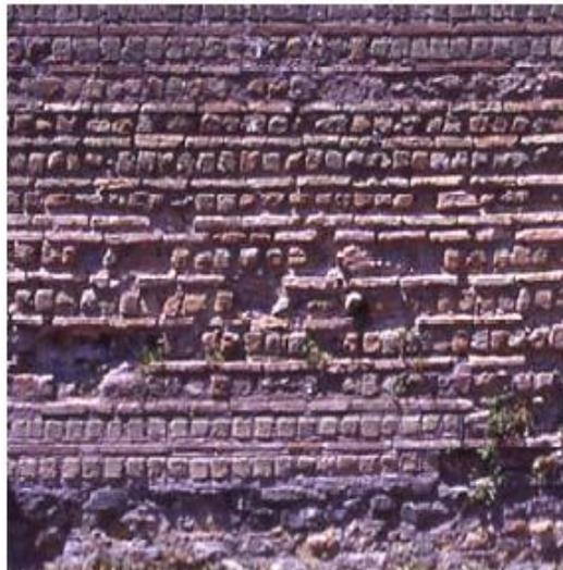
Fig.1.17. Opus mixtum à panneaux<sup>26</sup>.
