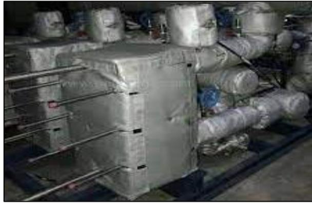
Figure III.7 : Gilet d'isolation d'un échangeur à plaques et joints
