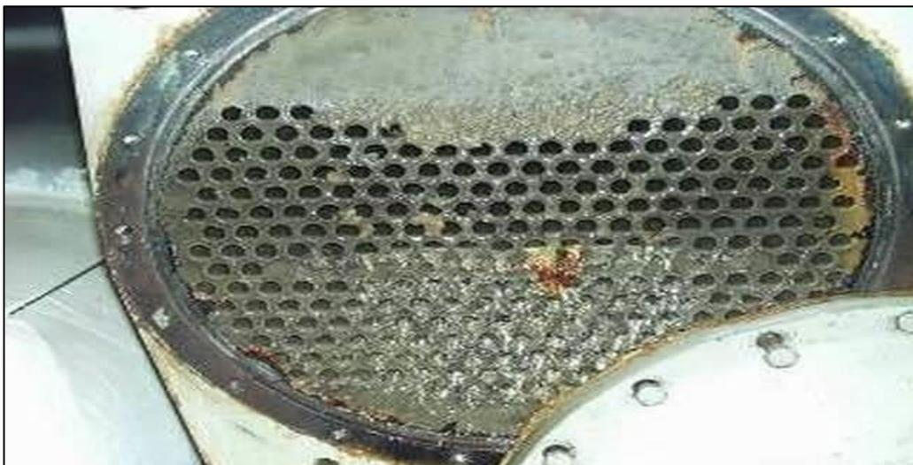
Figure III.1 : L'encrassement dans un échangeur tubulaire
