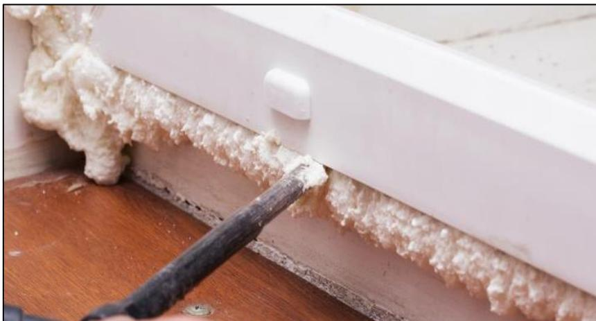
Figure III.7 : la mousse de polyuréthane
