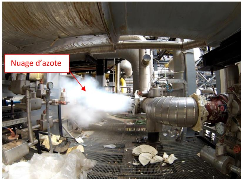
Figure V.13 : opération de soufflage de la ligne 18 (entrée 17-MC02)
