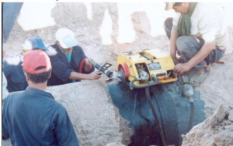
**Figure V.10** : Début de coupe : réglage de la vitesse de la machine.
