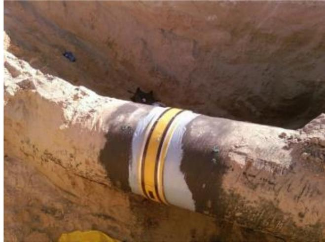
**Figure V.2 :** Réparation par CLOCK SPRING finie
