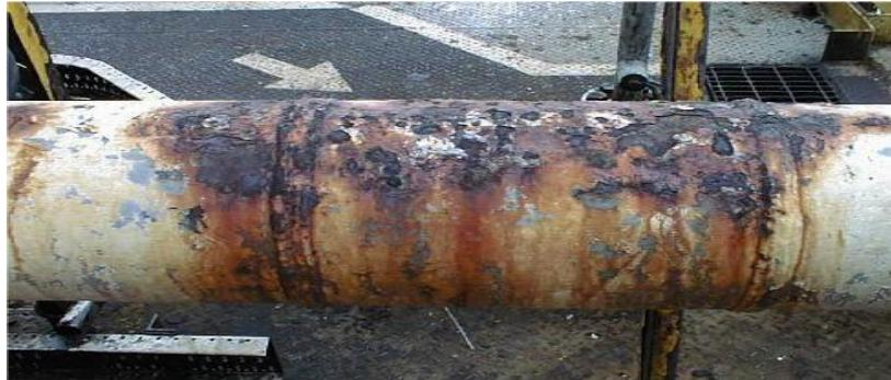
**Figure II.15 :** Corrosions externe en pipeline.
