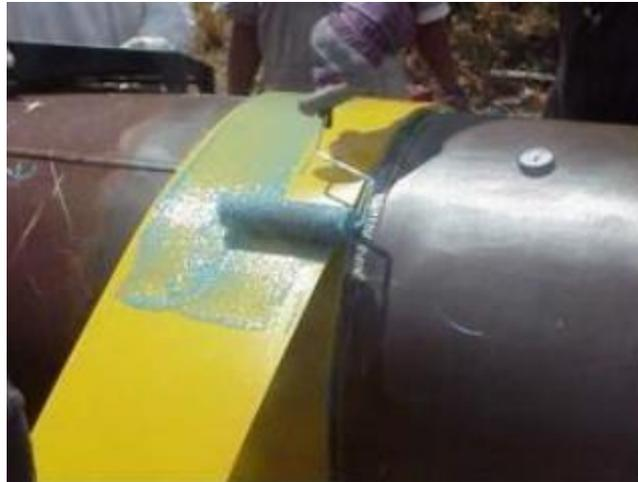
**Figure V.1** : Application de la résine sur les feuilles du CLOCK SPRING.
