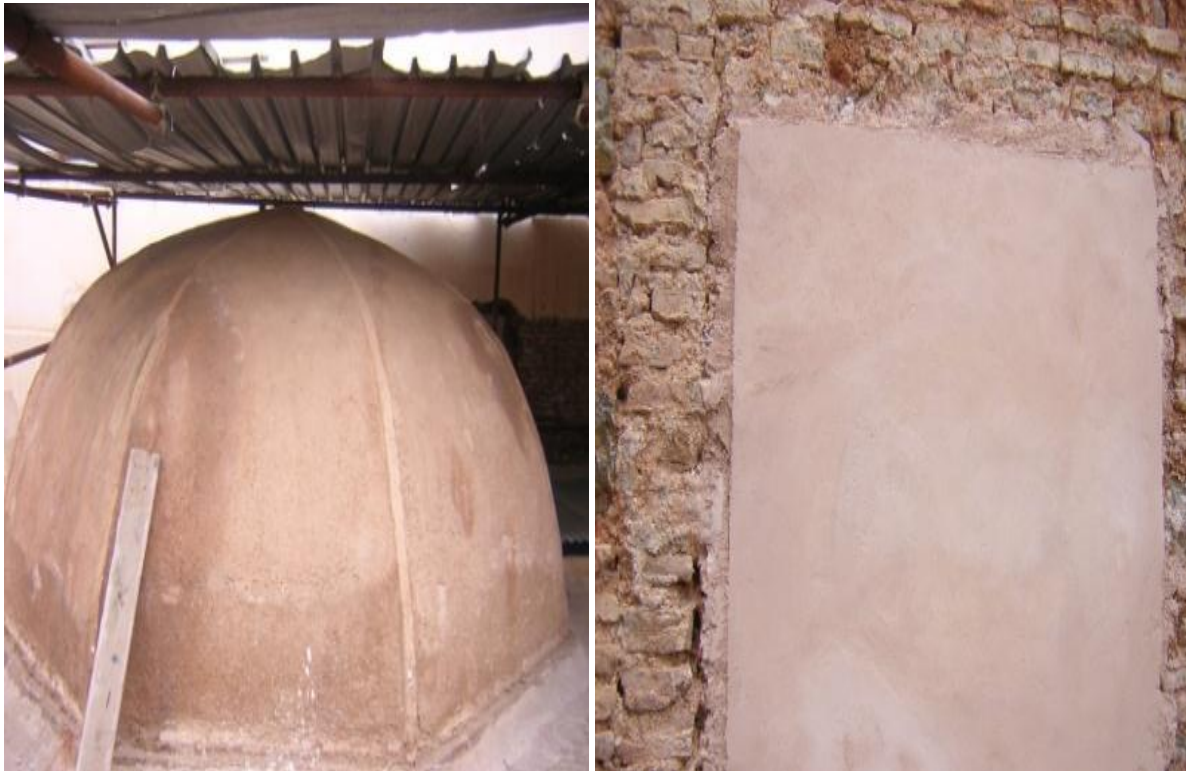
Fig.5. Application des mortiers in-situ (La citadelle d'Alger). 37
