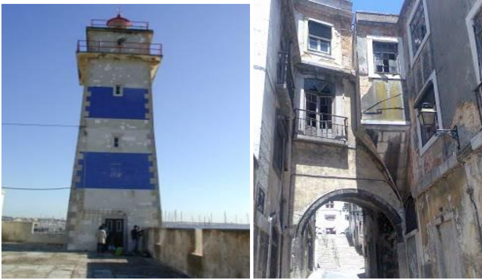
Fig.4.la forteresse de Santa Marta à Cascais et le mur de défense de la ville de Lisbonne . 35
