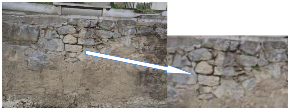
Fig.42. Perte de masse des pierres et mortier d'un mur intérieur de la piscine. (M. Belaidi).
