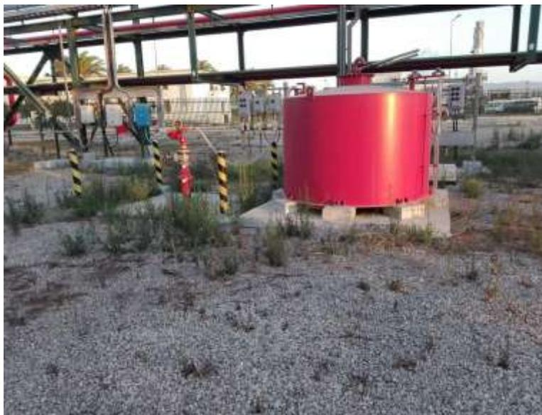
**Figure III 4 : les skids a émulseur fixe.**
