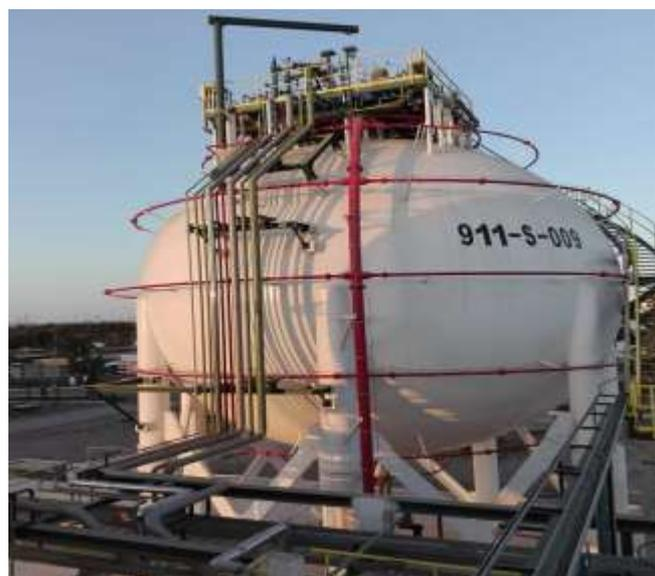
**Figure III .2 : les couronnes de refroidissement.**
