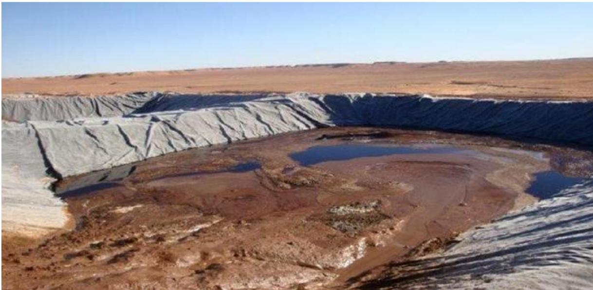
Figure (III.3) : borbier conventionnel (volume =3800m<sup>3</sup>, liner de mauvaise qualité).
