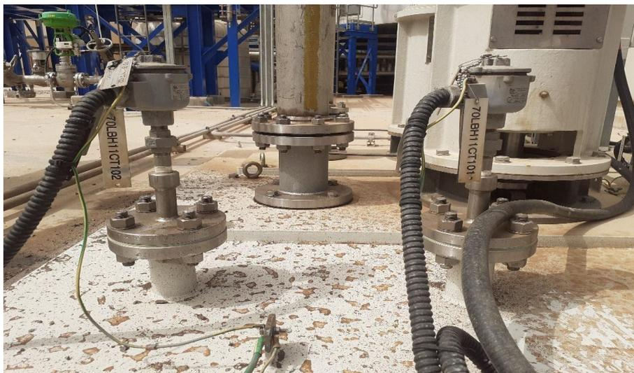
Figure II.13 :capteur de température.
