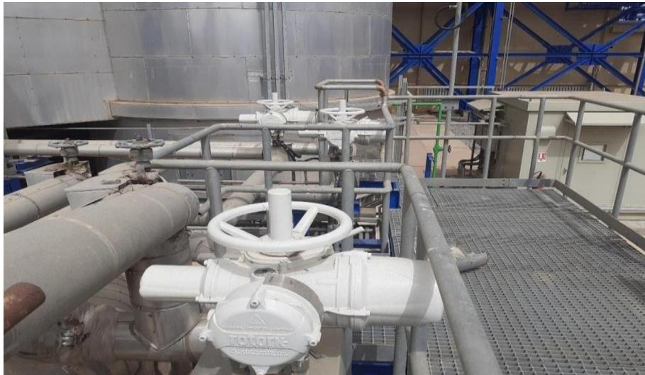
Figure II.4 : Vannes motorise de commande des purges
