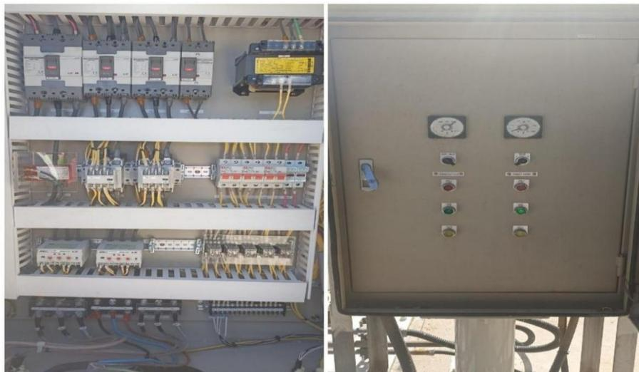
**Figure II.19: armoie électrique**
