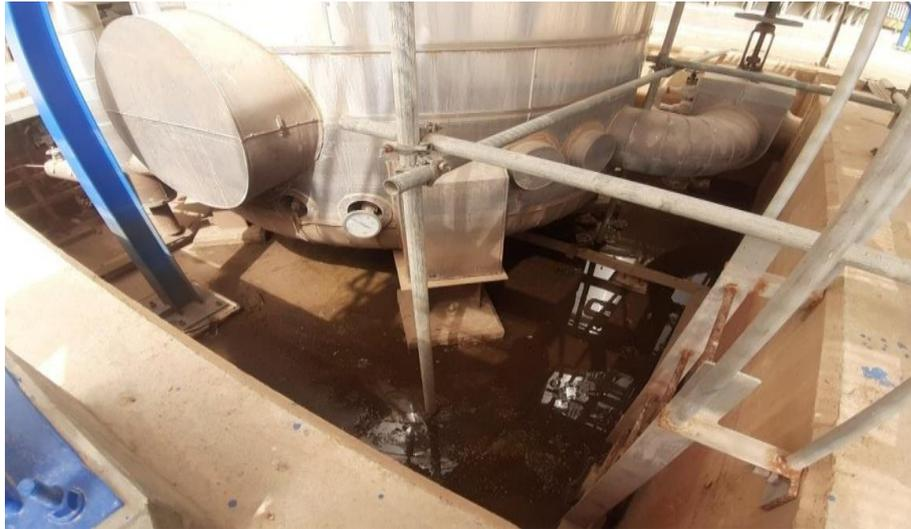
Figure II.3 : Siphon de décharge d'excès d'eau dans les conditions d'urgence
