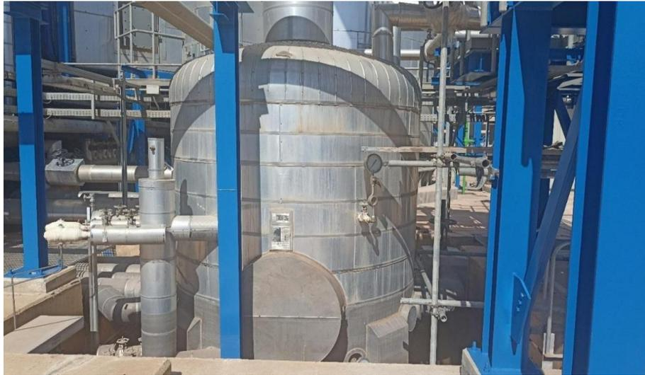
**Figure II.1 : Réservoir des purges.**
