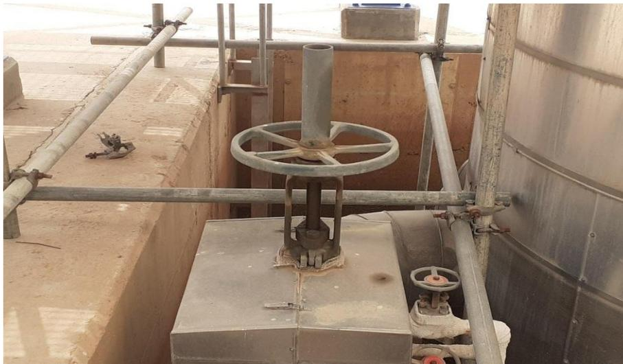
**Figure II.17 : vanne de Transfer vers le bassin collecteur**
