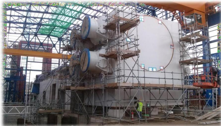
**Figure I.13 : Le condenseur à Surface avec Éjecteur d'air à jet de vapeur**
