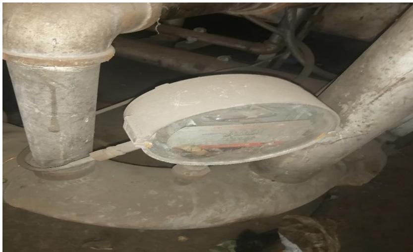
Figure I. 8 : Pressostat de pression gaz et air naturel.
