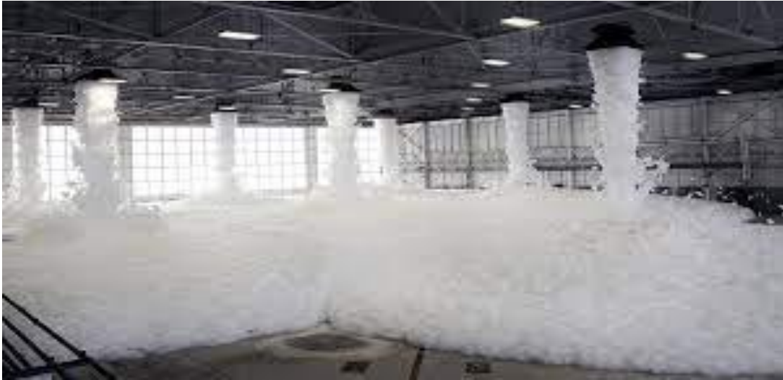
Figure II.21 : extinction d'incendie avec la mousse
