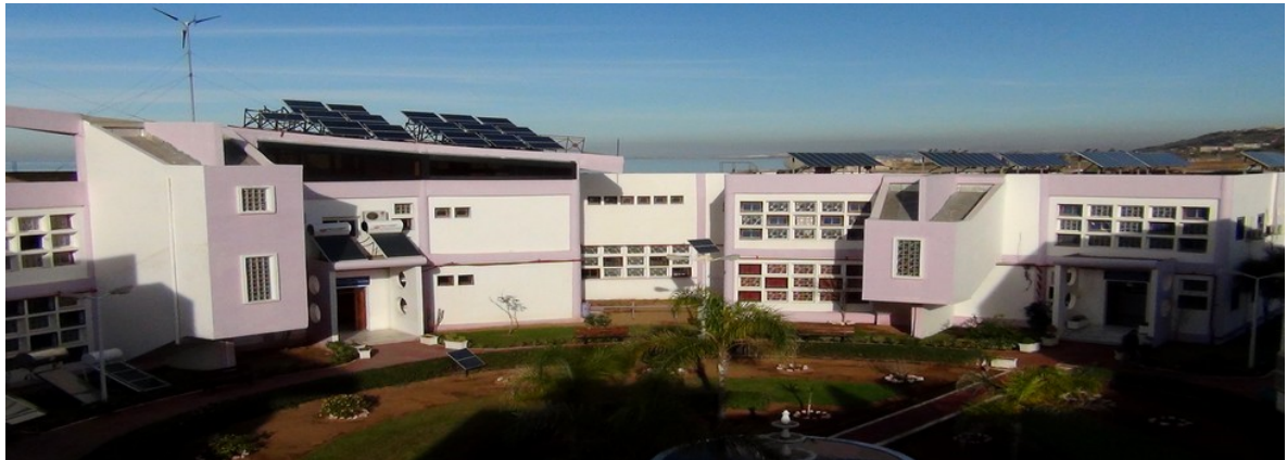
Figure III.1 — Unité de Développement des Equipements Solaire.
