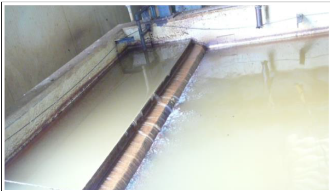
Figure I.1 — Bassin séparateur CPI.
