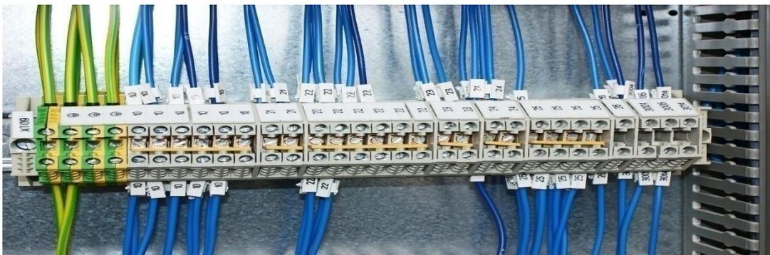
Figure II. 7: Bornier électrique
