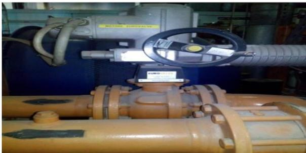
**Figure II.3** : Vanne de recyclage automatique.
