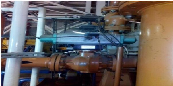
**Figure II.1** : Vanne d'arrêt à bille.
