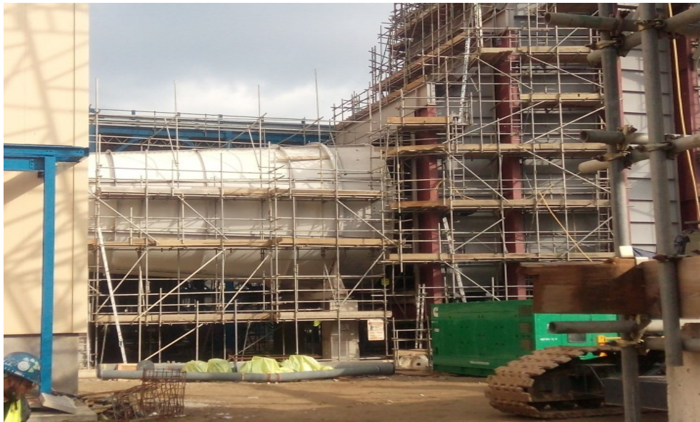
Figure I.4. Diffuseur de la turbine
