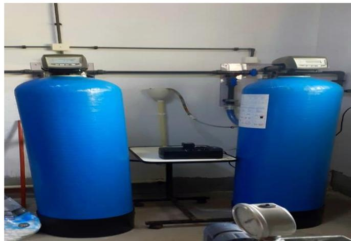
Figure 22: Filtre à sable de la salle d'eau de l'hôpital de 'Thenia'
