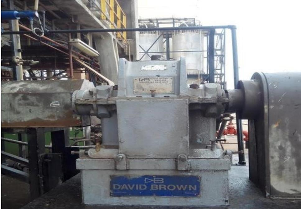
Figure II.9 : Multiplicateur de la pompe réacteur
