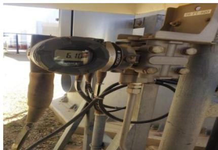
**Fig. II.1** Transmetteur de la pression d'air instrument PT920.
