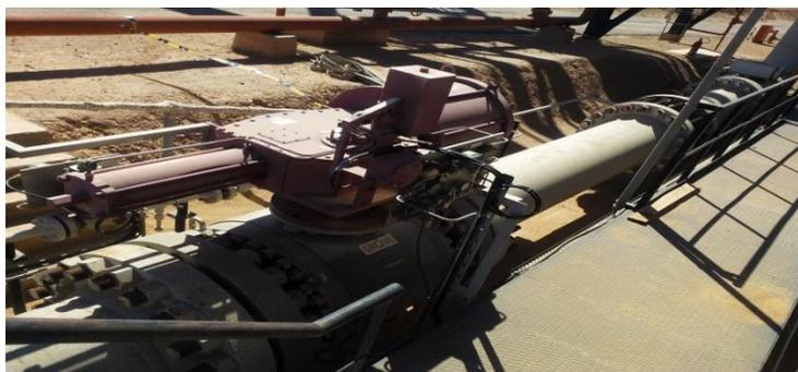
**Fig.II.5.** Vanne de refoulement XV921 vers MPP0.
