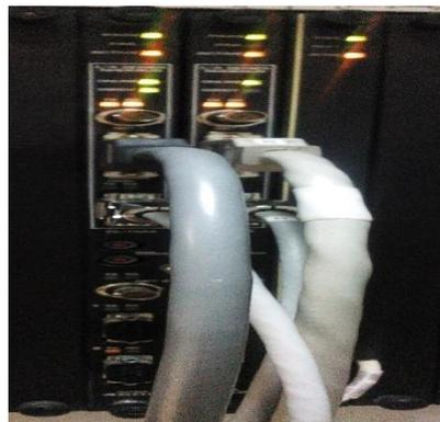
**Fig.II.16** ACM (lié au DCS et à l'interface homme machine HMI).
