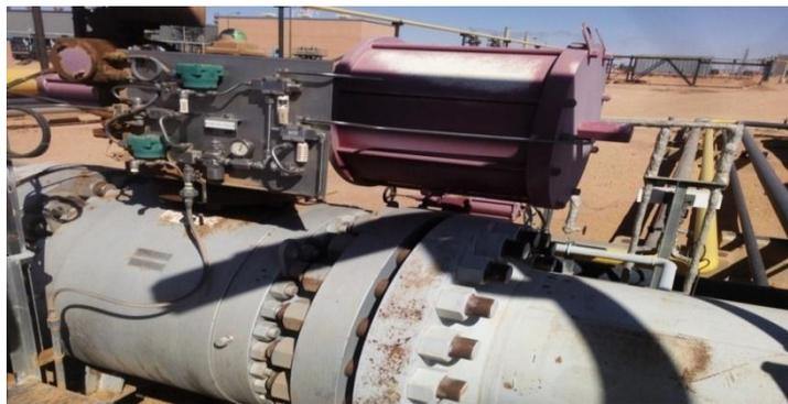
**Fig.II.4** Vanne de refoulement XV920 vers MPP4
