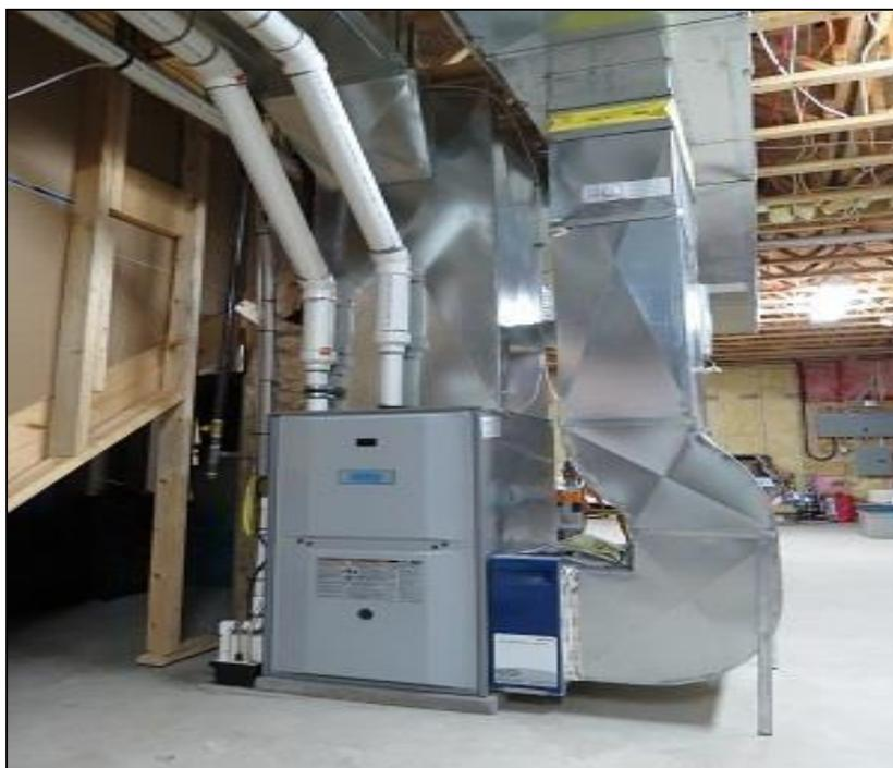
**Figure I.2** : Chauffage à air pulsé.
