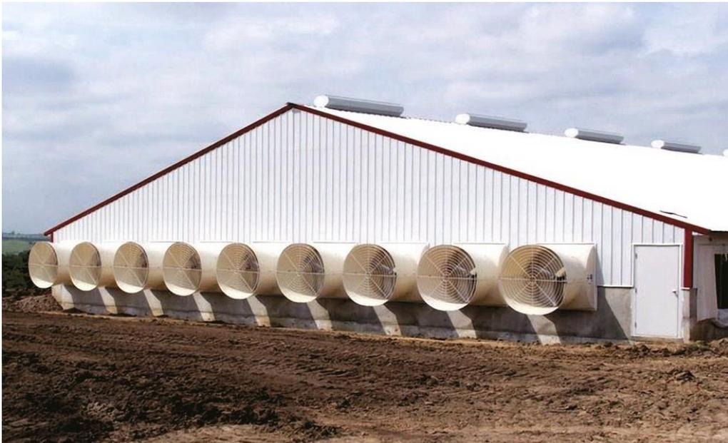
**Figure I.6** : Exemple type d'un bâtiment équipé d'une ventilation en tunnel.
