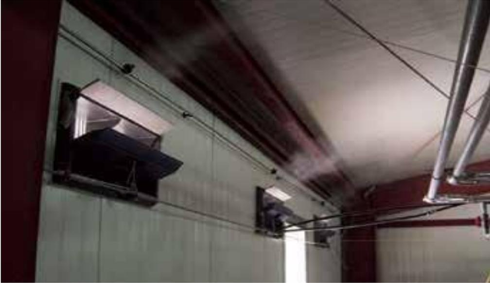
**Figure I.8 :** Exemple de système de brumisation dans une poulailler.
