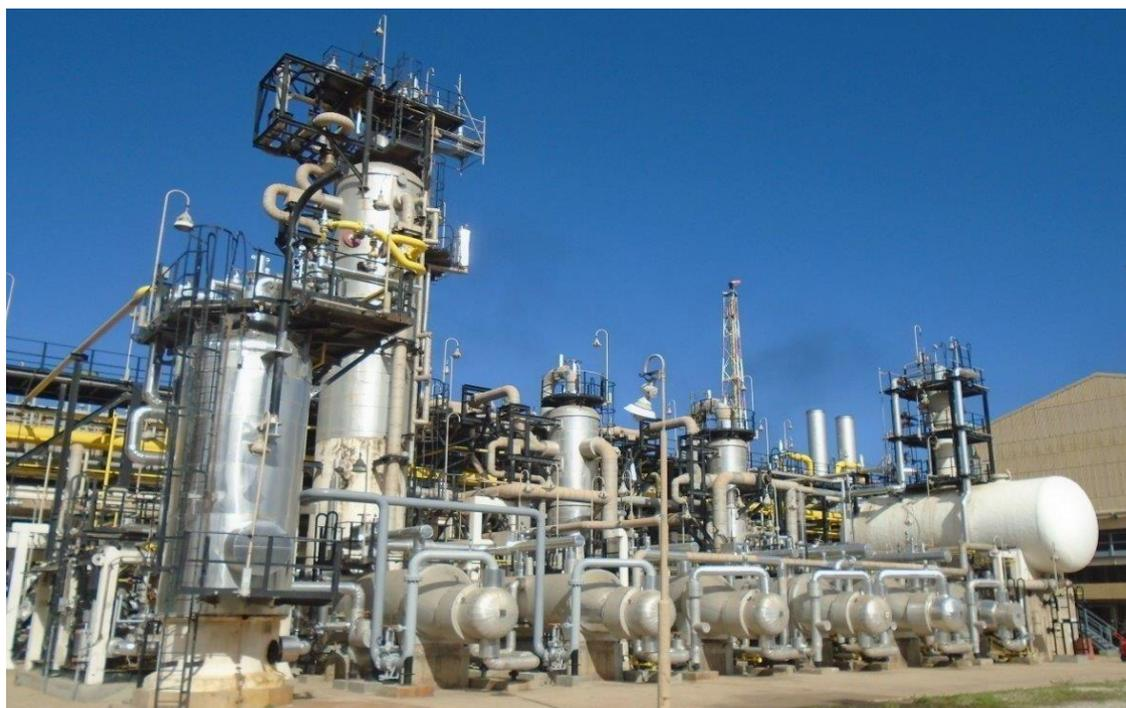
**Figure I.7 :** Les équipements de la section de réfrigération.
