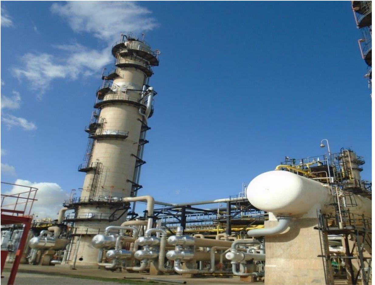
**Figure I.6:** colonne de séparation (Fractionnateur).
