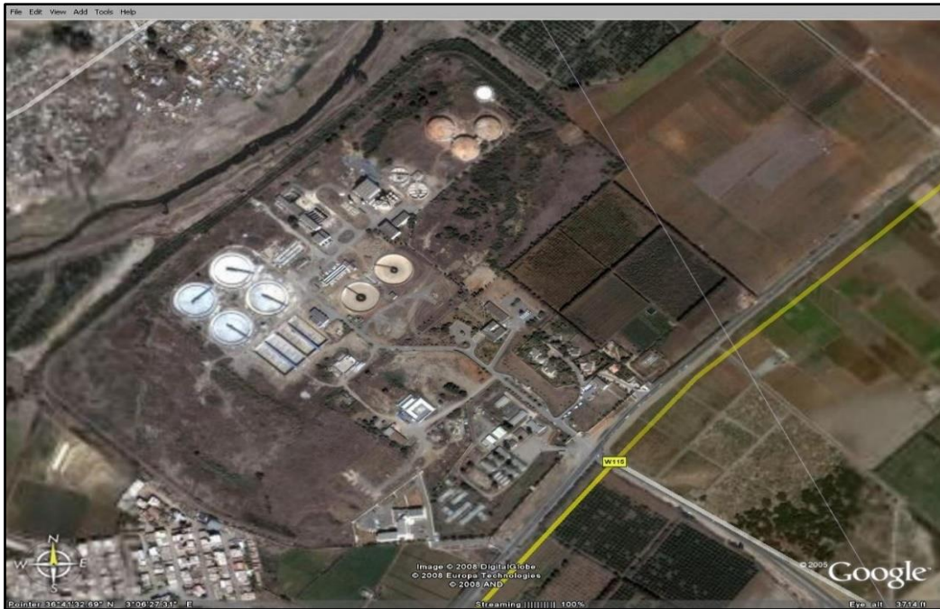
Figure 3 : Situation géographique de la raffinerie [9]
