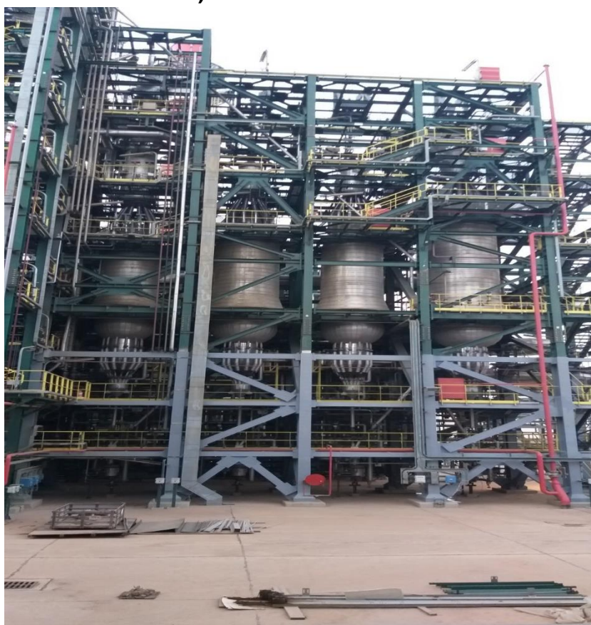
Figure III.7 : Illustration des 4 réacteurs en série de l'unité CCR
