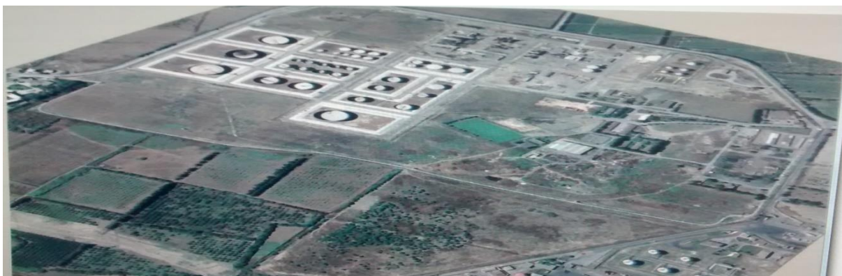
Figure I.1 : la raffinerie Avant réhabilitation.
