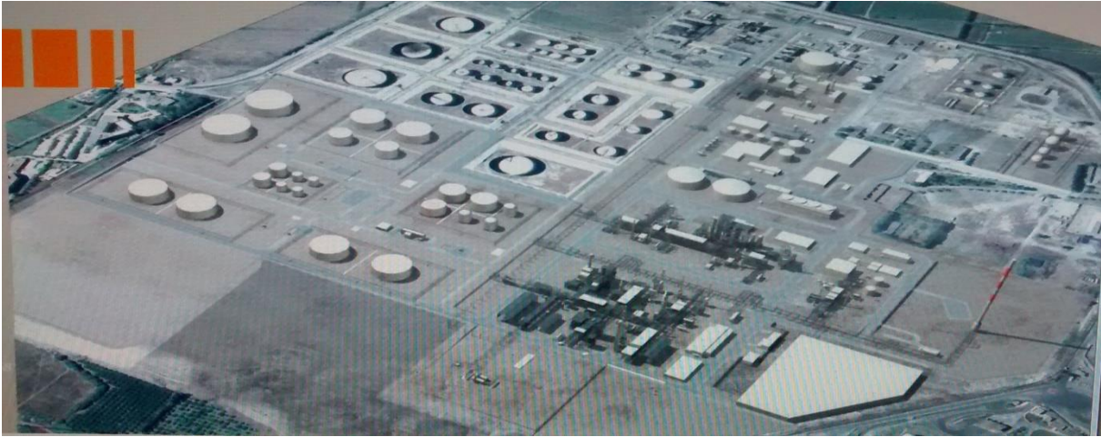
Figure I.2 : la raffinerie après réhabilitation.
