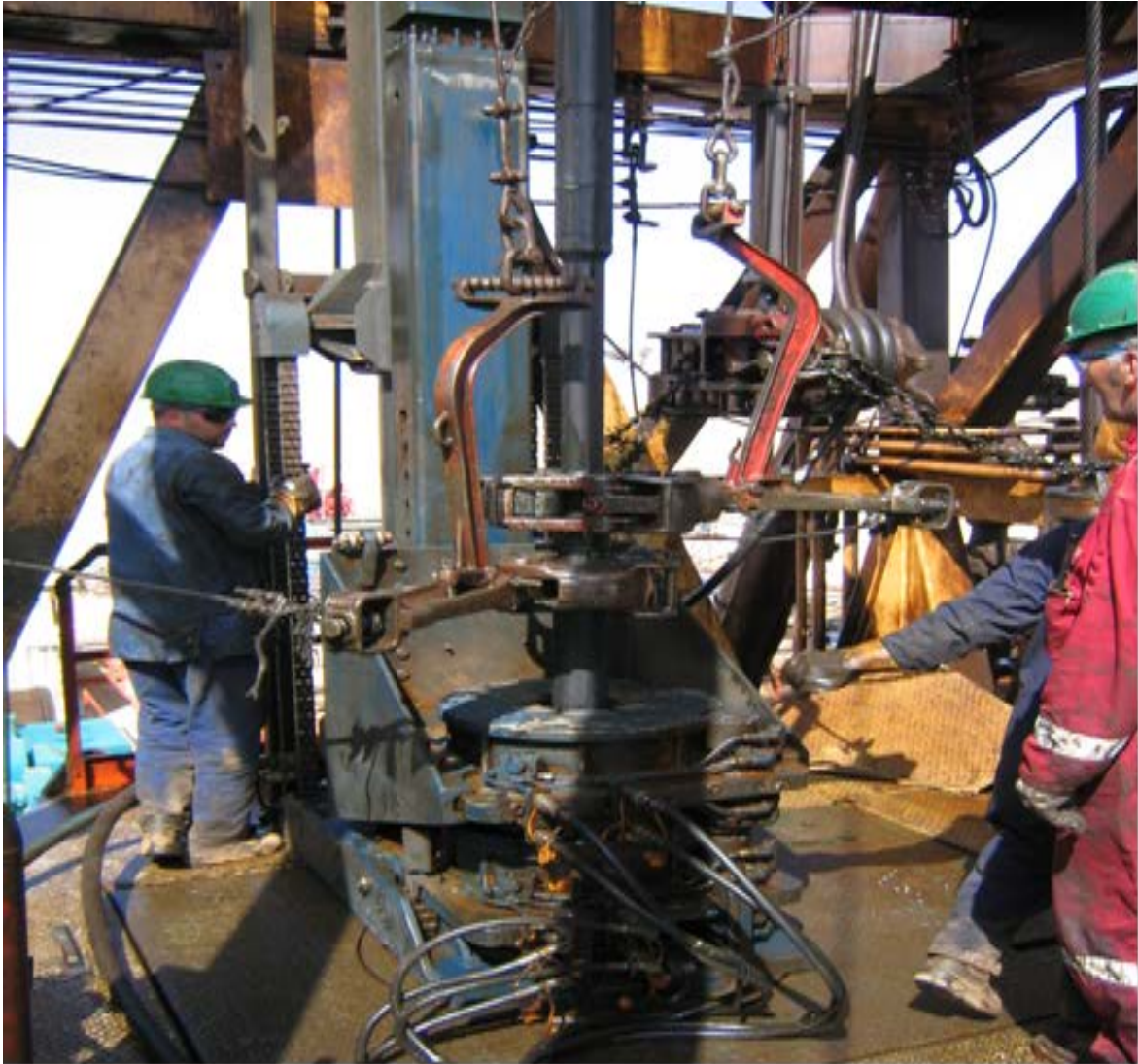
Figure II-14 - PPM sur chantier
