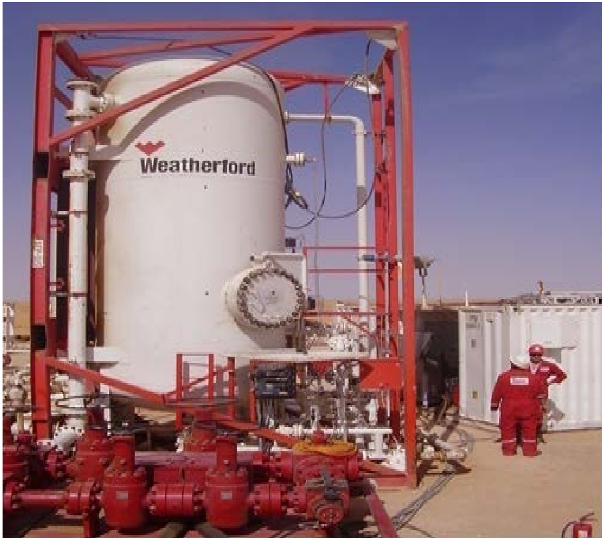
Figure II-19 - Séparateur Vertical sur chantier
