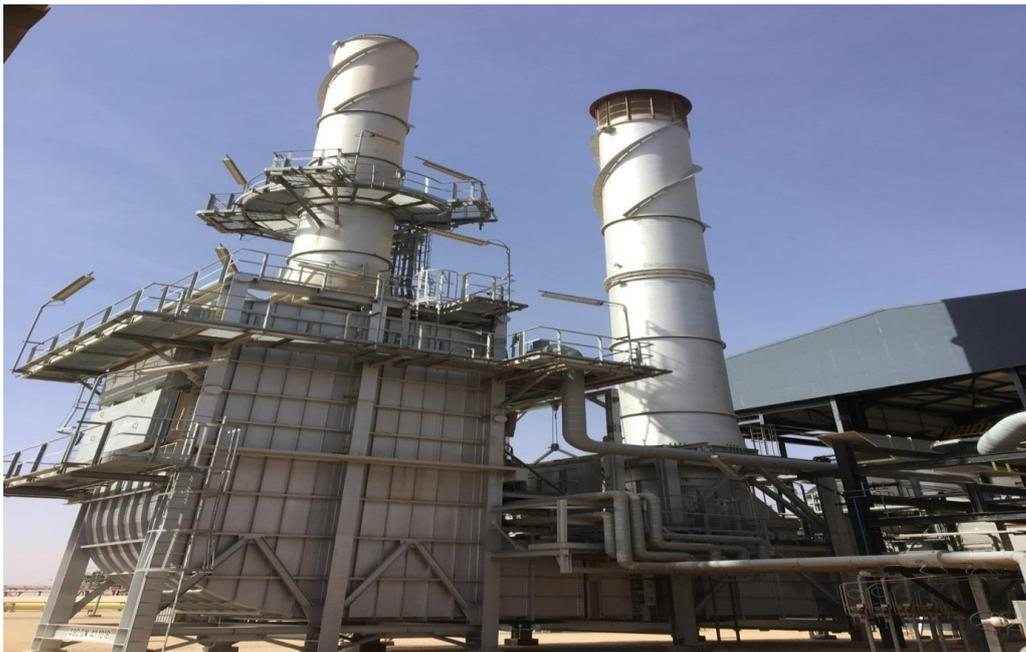
*Figure IV.4 : Echappement et récupérateur de chaleur du turbocompresseur unité G50*
