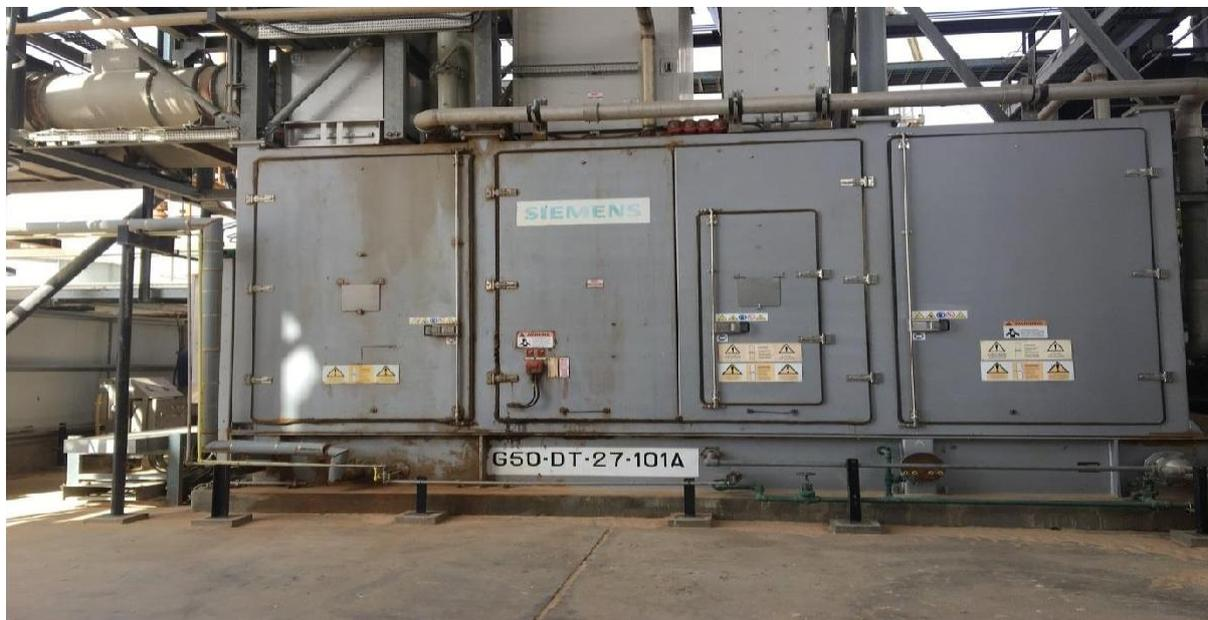
*Figure IV.3 : Turbocompresseur de gaz résiduel unité G50*
