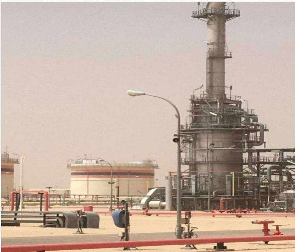
*Figure IV.5 : Le réchauffeur d'huile a gaz (480-FA-41-101)*
