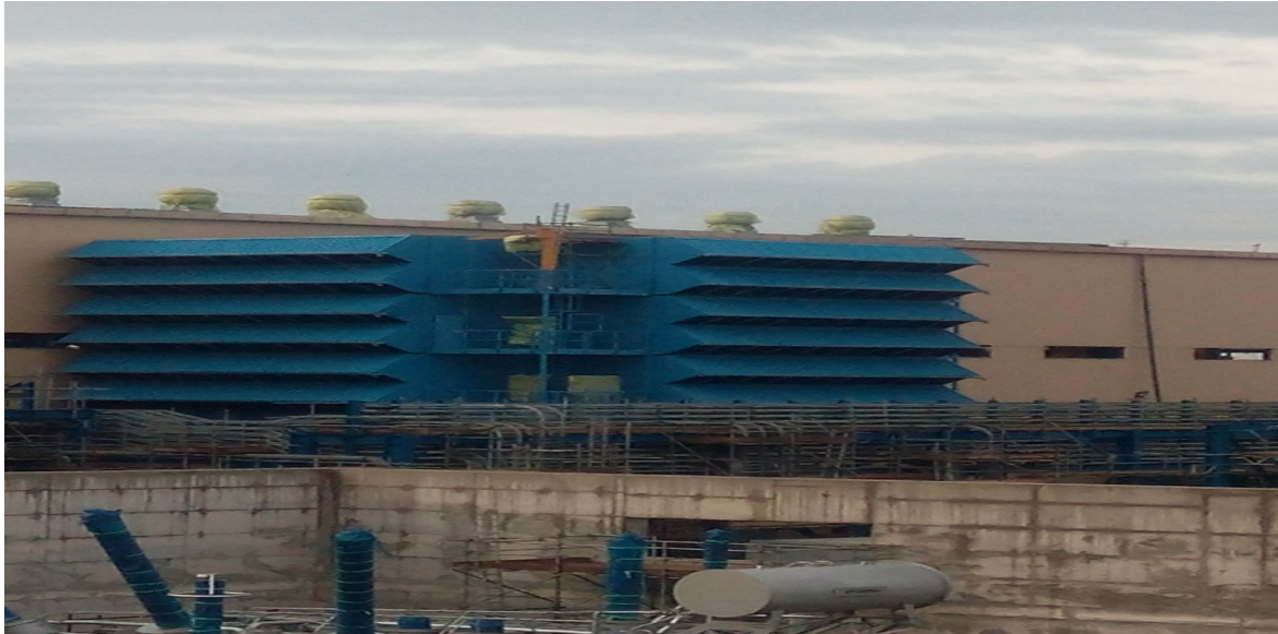
Figure1.3 : système d'admission air (50MBL)
