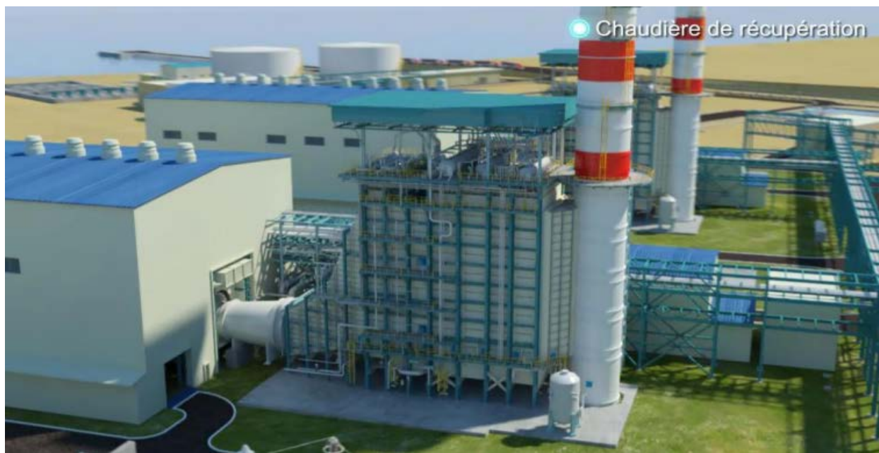
Figure 1.6 : Chaudière de récupération
