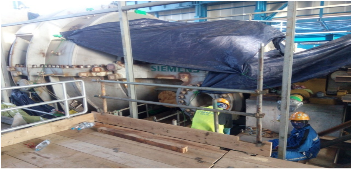
Figure1.8 : Turbine à vapeur SST5-3000 H-IL(SIEMENS)
