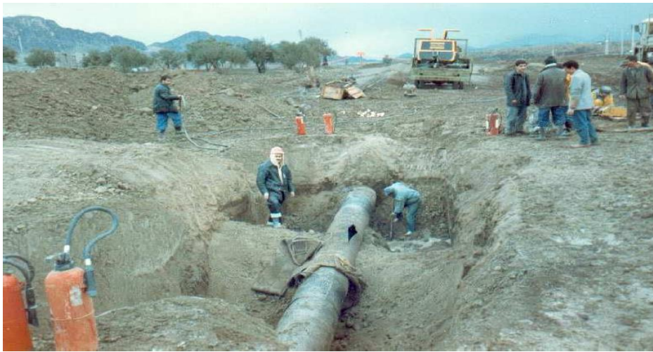
Figure III. 2: Excavation d'un tronçon
