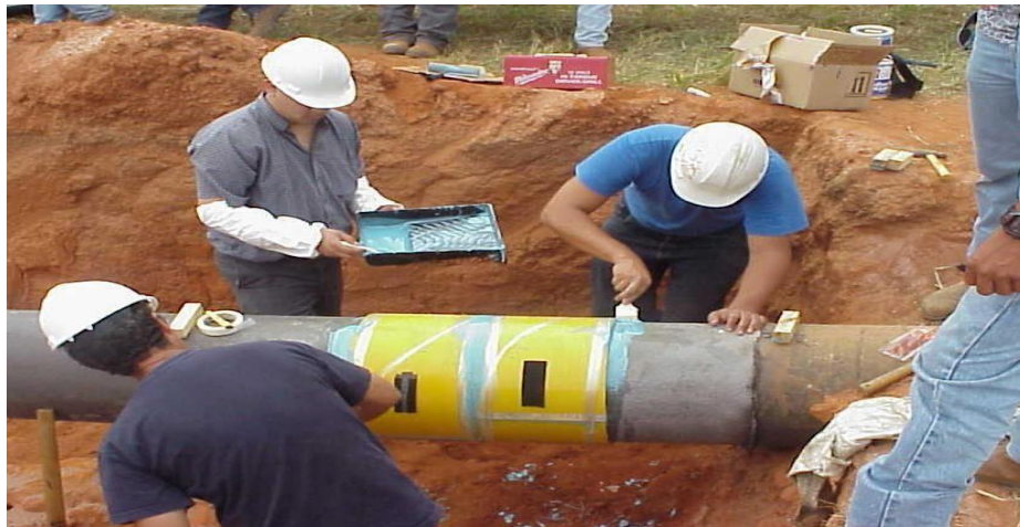
Figure III. 10: Opération de réparation par manchons
