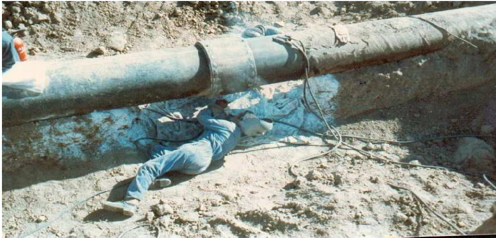
Figure III. 4: Soudage d'un manchon de raccordement.
