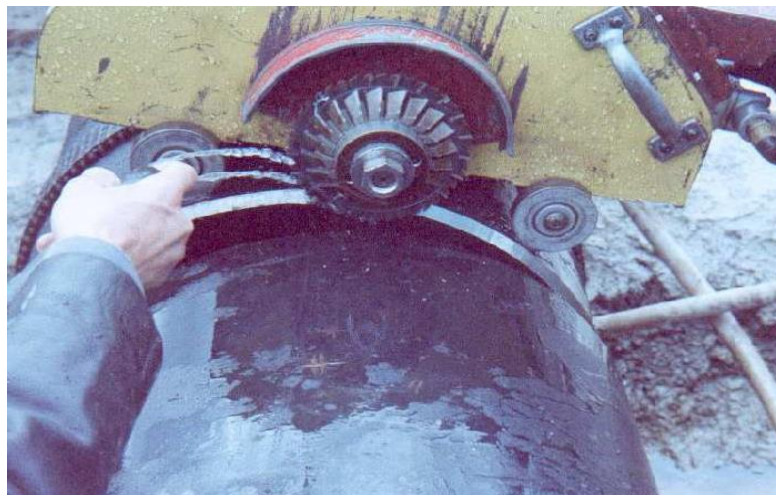
Figure III. 3: Opération de coupure du tronçon
