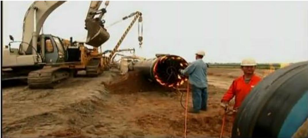
Figure (II-09) : Préchauffage des tubes
