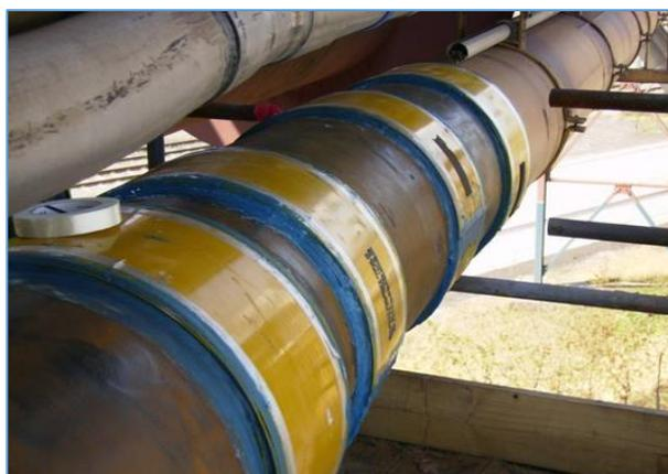
**Fig. V.3.b** : Une conduite réparée par des CLOCK SPRING.
