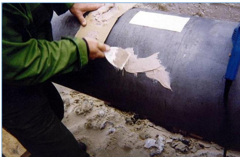
*Fig. V.5 : La pose d'un mastic sur les crevasses ou les soudures.*
