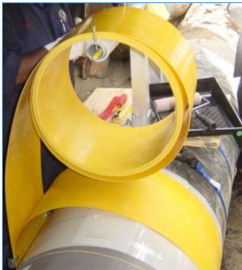
*Fig. VI.4 : Un rouleau de CLOCK SPRING*
