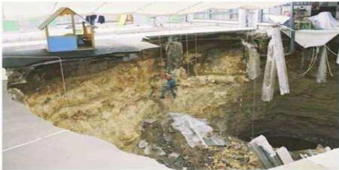
Figure 2-4 : Effondrement du métro de Paris 02-2003
