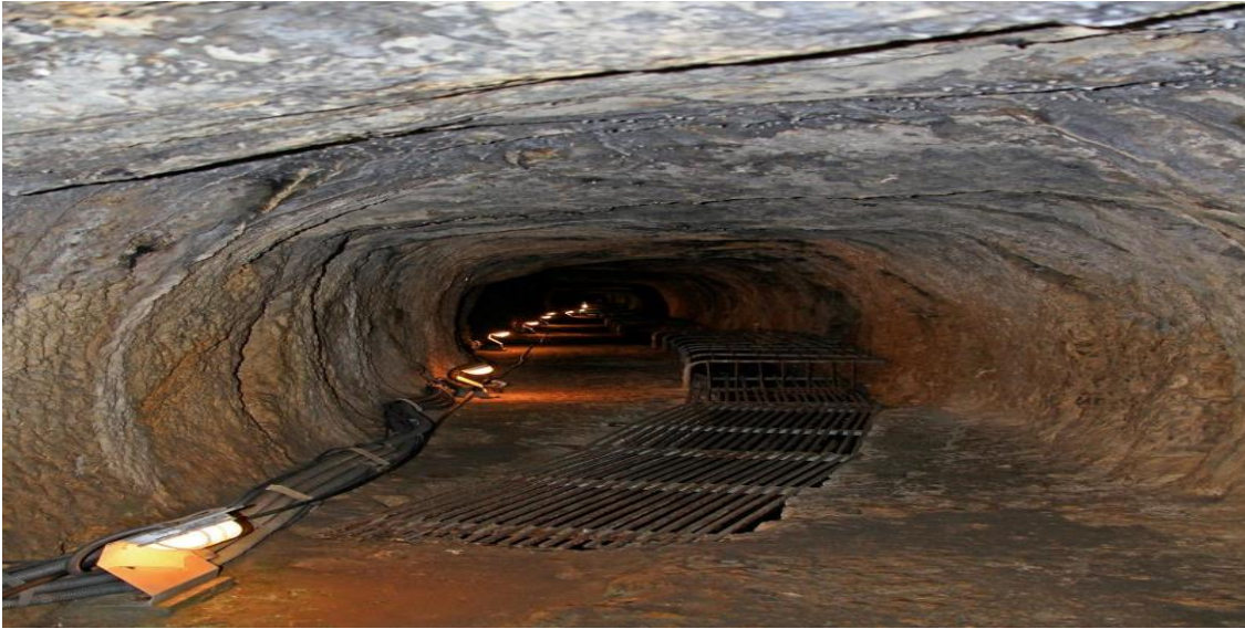
Figure 1-2: Galeries de canalisations
