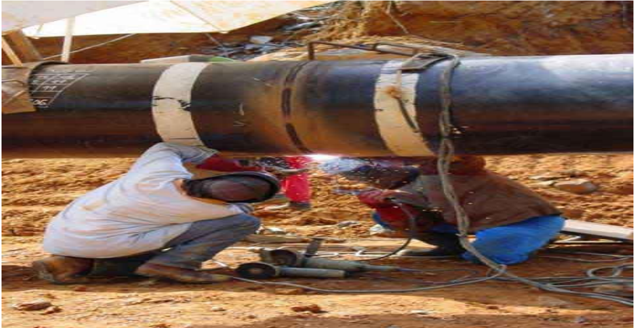
Fig.3.2 : Soudage à l'électrode enrobée dans l'industrie
