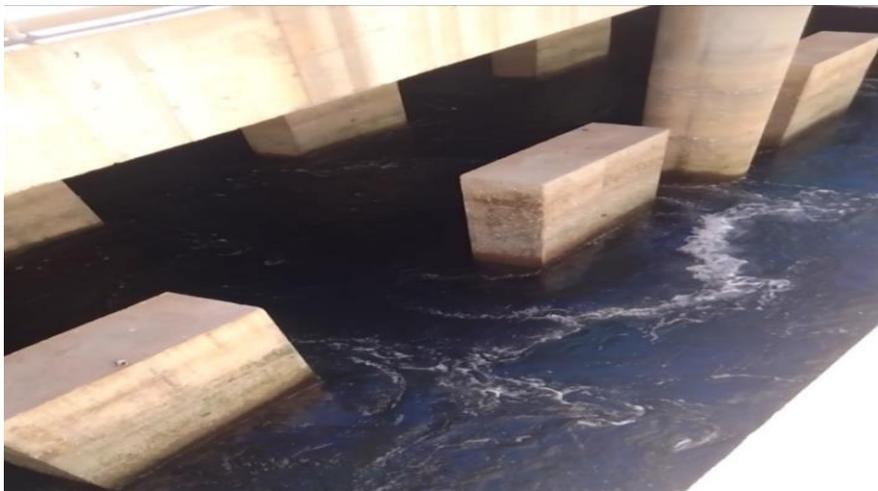
**Figure II.5:** Les brise-lames de la centrale (CC)
