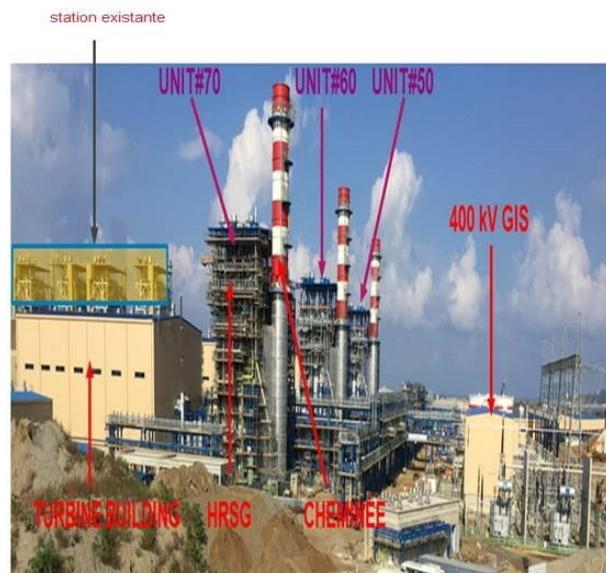
*Figure I.3: Schéma synoptique de module (groupe) de la nouvelle station. [3]*
