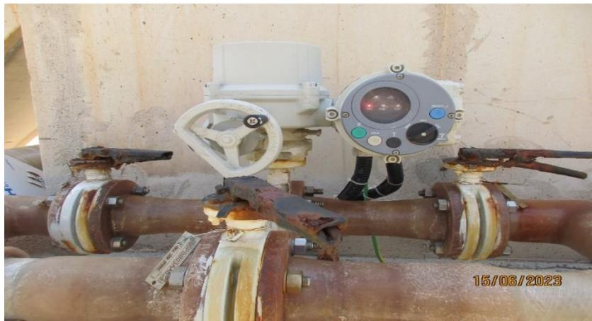
Figure II.23: La Vanne motorisée de la station
