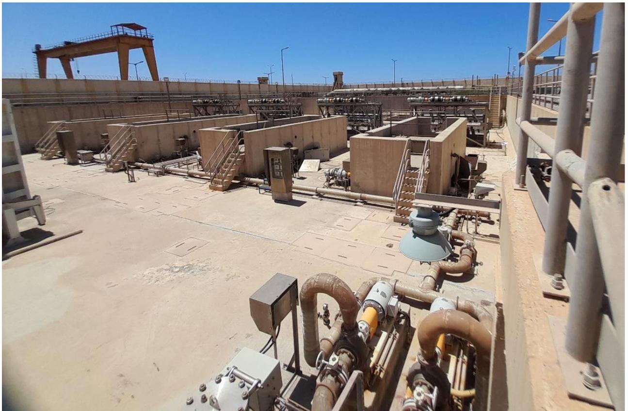
*Figure II.1: L'installation d'entrée d'eau de mer*
