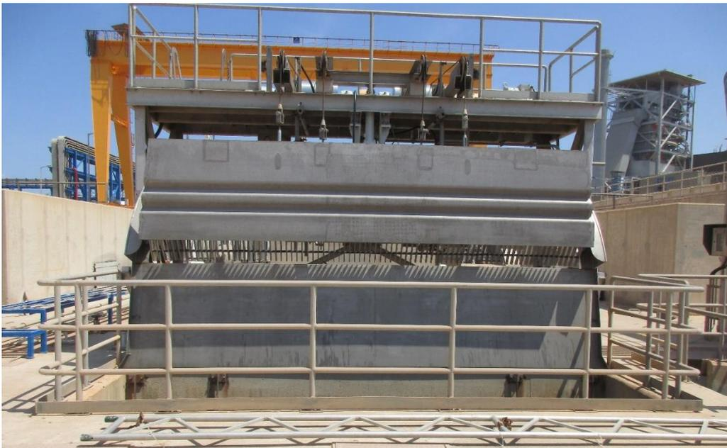
*Figure II.6: Les grilles à barreaux de la centrale (CC)*
