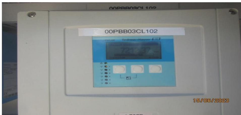
Figure II.16: Capteur de niveau ultrasonique [20]
