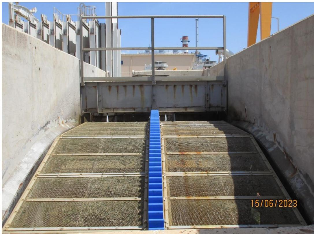
*Figure II.7: Le filtre tamis rotatif*
