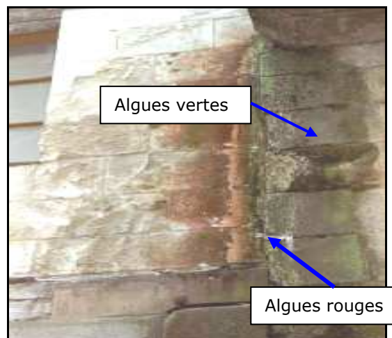
Figure 30 : Développement d'algues vertes et rouges sur un mur calcaire exposé à un écoulement d'eau [15].
