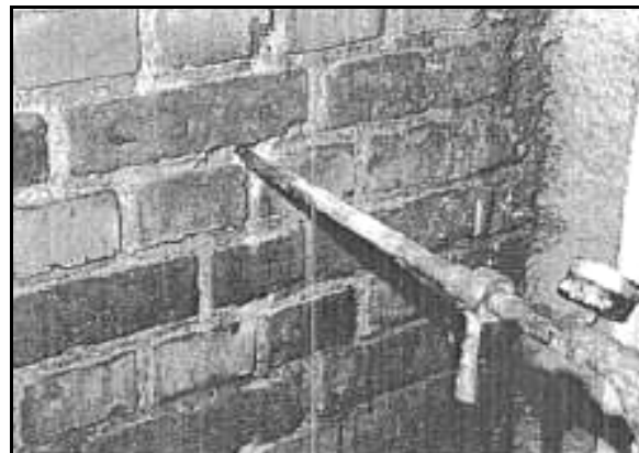
Figure 45: Injection d'un produit hydrofuge.
