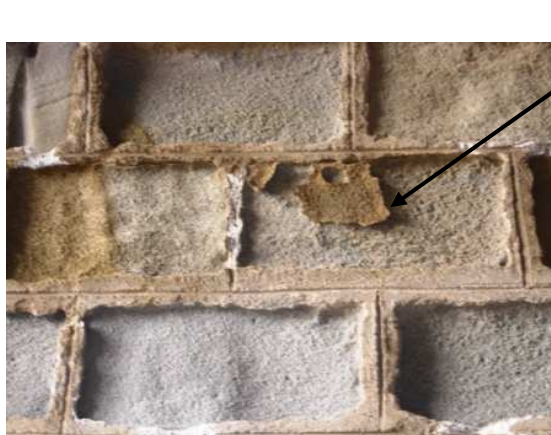
Figure17: Altérations en plaques. en pierre à Dellys.
