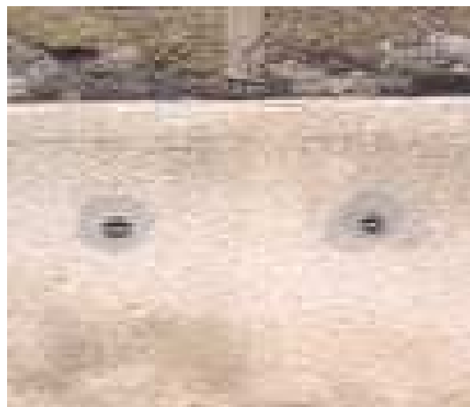
Figure 43 : Siphons atmosphériques placer en bas de mur [17].
