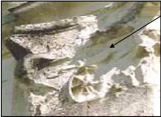
Figure 7: Erosion de relief sculpté en pierre Calcaire [15].
