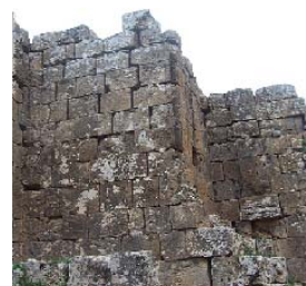
Fig. n° 004 : Photo de la façade du mur adjacente au théâtre
