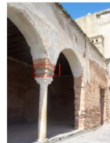
Fig. n° 02 : Photo montrant l'utilisation des rondins du bois dans les structures.
