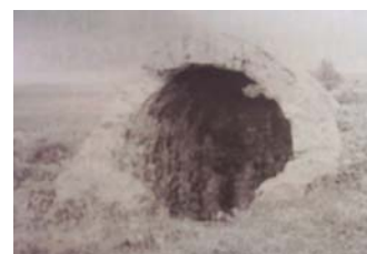
Fig. n° 04 : Four à chaux de Marcel Lavie située sur la route de Sedrata wilaya de Guelma.
