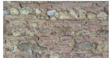
Fig. n° 01 : Mur composé de pierre et de brique liées par un mortier de chaux.
