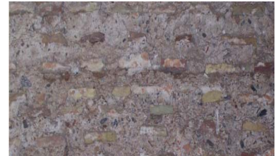
Fig. n° 009 : Photo montrant la composition du mur banché.
