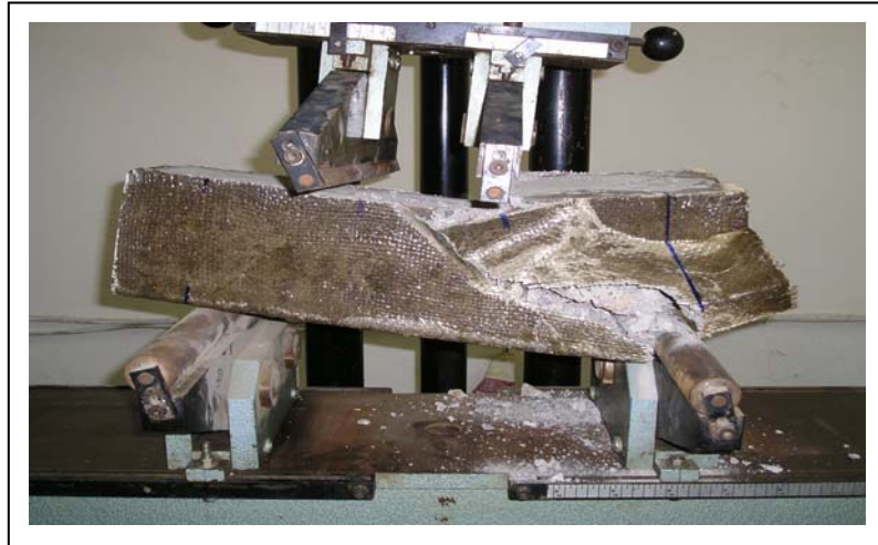
Figure IV.21. Mode de rupture du béton fissuré réparé par chemisage complet
