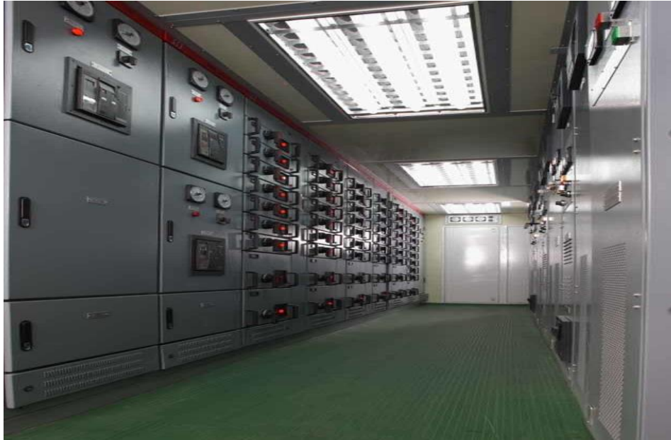
Figure 17: La chambre électrique SCR
